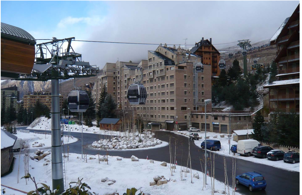
Imatge des de la cota d'embarcament
