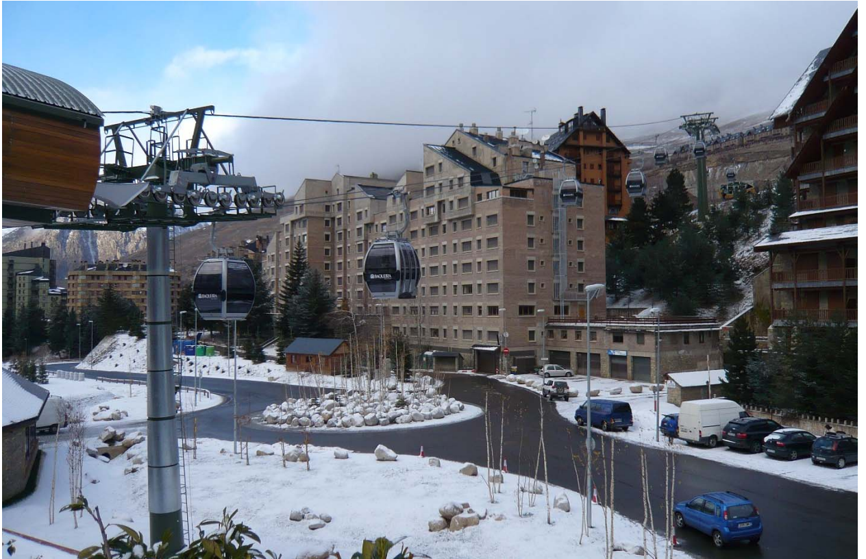
Imatge des de la cota d'embarcament
