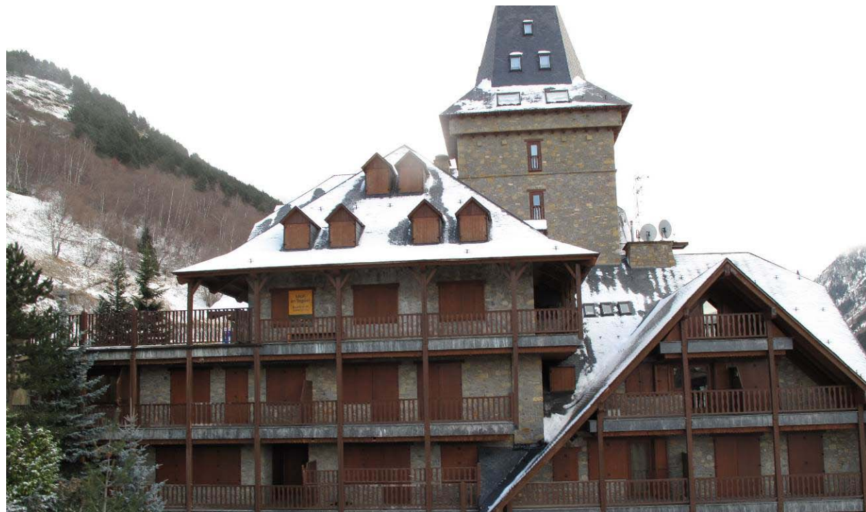
Foto 10. . Façana de l'edifici Port de la Bonaigua des del telecabina que surt de Ruda
