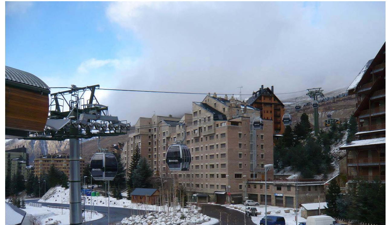
Foto 3. Recorregut inicial del telecabina des de la UA-2 Ruda, cap a l'estació intermitja a Baqueira 1500
