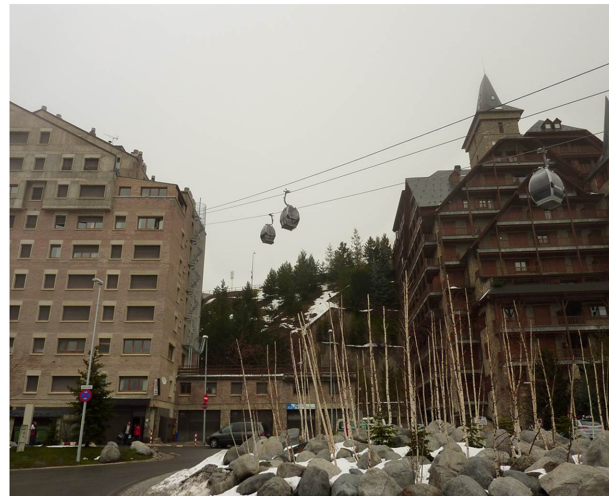
Fotomuntatge on s'aprecia la nova instal·lació al seu pas entre els edificis Solneu a l'esquerra, i Port de la Bnaoigua a la dreta.
