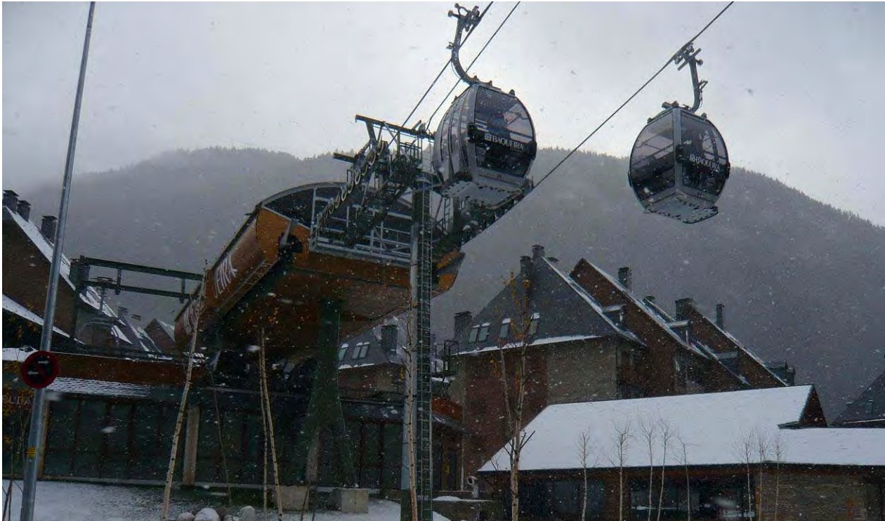
Foto 1.Sortida del telecabina des de la terrassa sobre aparcament soterrat de la UA-2 Ruda
