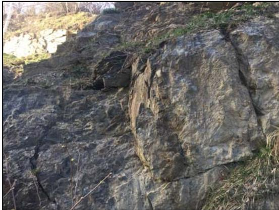
Este talud, en la parte posterior de la multipropiedad, presenta una altura de 10 metros y presenta una pendiente de aproximadamente  $70-80^\circ$ , se pueden ver los materiales metamórficos del sustrato original de los materiales. Los taludes se presentan estables y protegido superficialmente en algunas zonas por tierras vegetales. Sólo se aprecian los materiales de alteración superficial disgregados en el pie del mismo.
