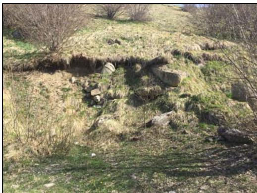
Este talud presenta una altura de 5 metros y presenta una pendiente de aproximadamente  $45^{\circ}$ , se pueden ver bloques movilizadas superficialmente y tramos de terreno vegetal de 0.5 metros, este terreno vegetal se aprecia desgarrado respecto los materiales subyacentes.
