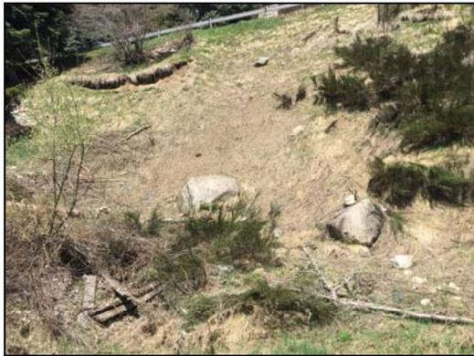
Este talud presenta una altura de 16 metros y presenta una pendiente de aproximadamente  $60-70^{\circ}$ , se pueden ver bloques en la base y tramos de terreno vegetal de 0.5 metros desgarrado respecto terreno subyacente.
