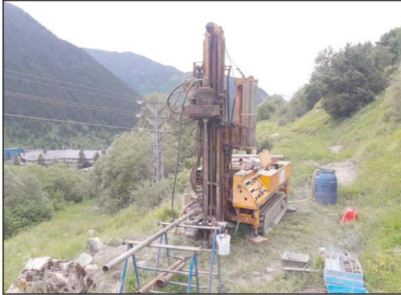
**Fotografía 1.** Máquina emplazada en el sondeo S-7.
