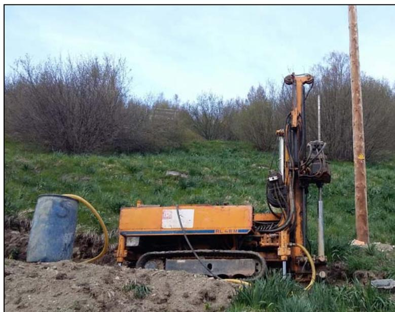
**Fotografía 7.** Ejemplo de emplazamiento de la máquina de sondeos realizando uno de los sondeos a rotación.
