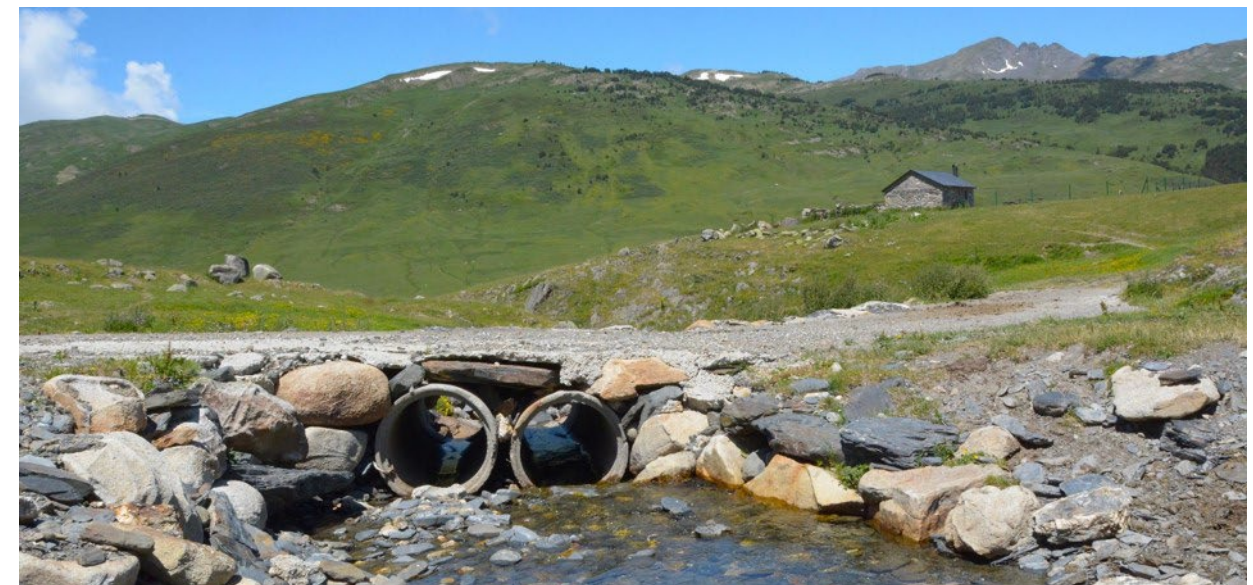
Tubs d'un cert diàmetre a l'Arriu de Beret permeten el pas de petits vertebrats allà on els rierols són interceptats per pistes.
