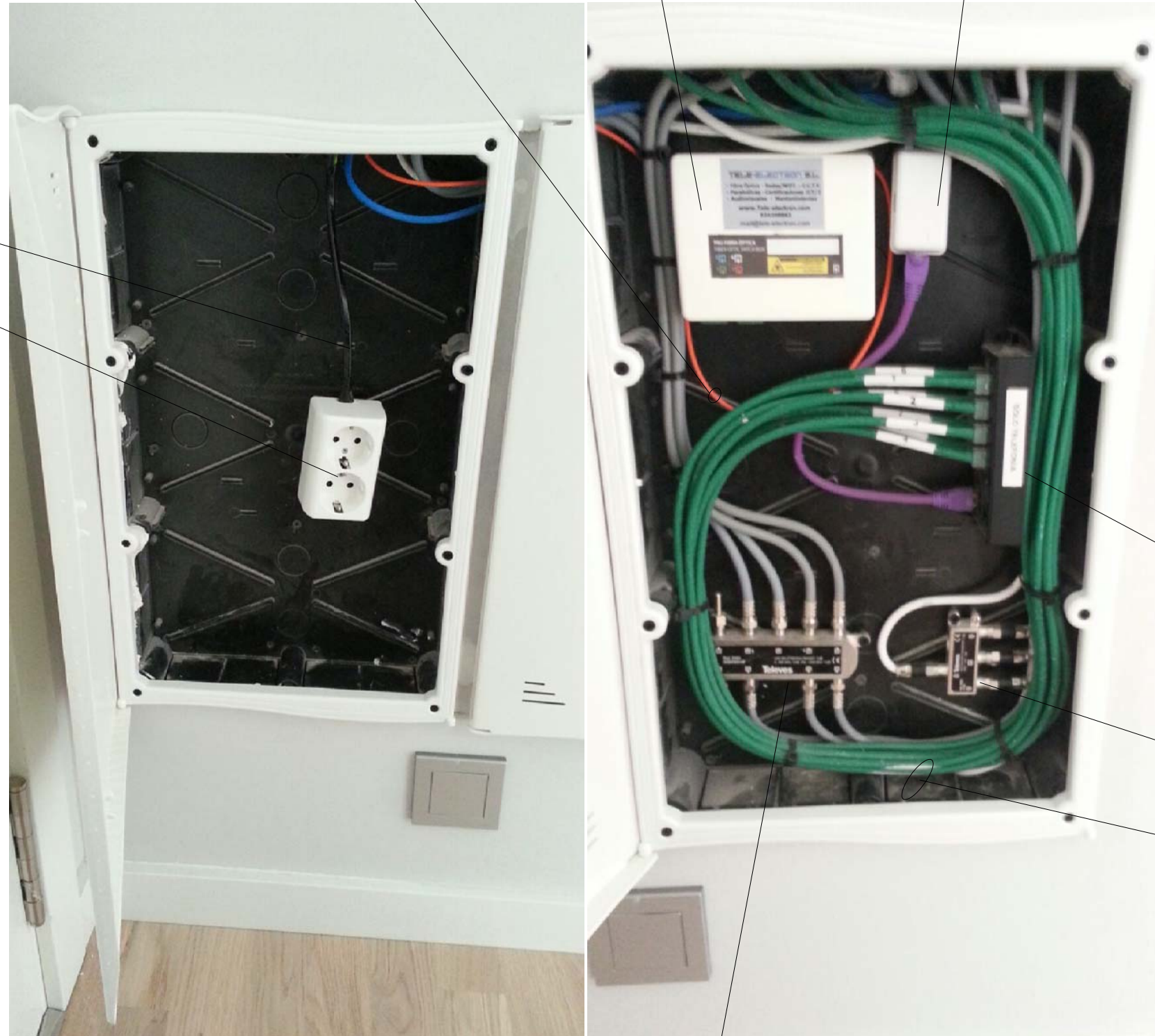
PAU del Servicio STDP con cables de pares trenzados
