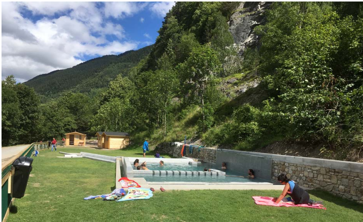
Vista de l'àmbit d'actuació de les piscines des de l'interior (al fons zona d'edificacions desmuntables)
