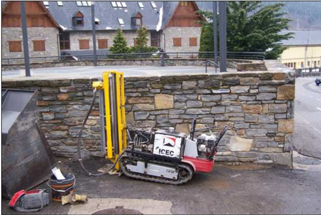
Foto-1: Vista parcial del solar a edificar. Ubicación del ensayo DPSH-1.
