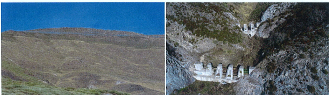
Imatges 7 i 8: a l'esquerra es veuen les proteccions per estabilitzar el mantell nival a la part alta del Barranc des Artigues i a la dreta els dos dics existents per aturar o disminuir l'energia d'una possible allau.
