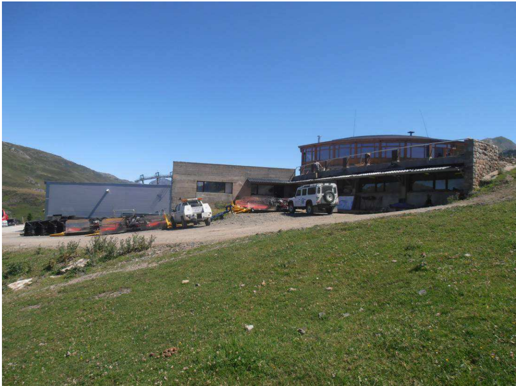
Vista lateral dels tres edificis adjacents d'esquerra a dreta: Ampliació del taller, taller, coberta del taller que fa de terrassa del restaurant i restaurant
