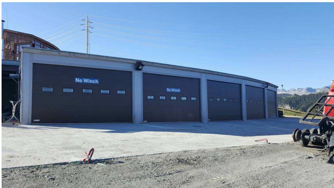
Vista en detall de l'entrada als 5 boxes, edifici que s'ha ampliat a partir del taller existent.
