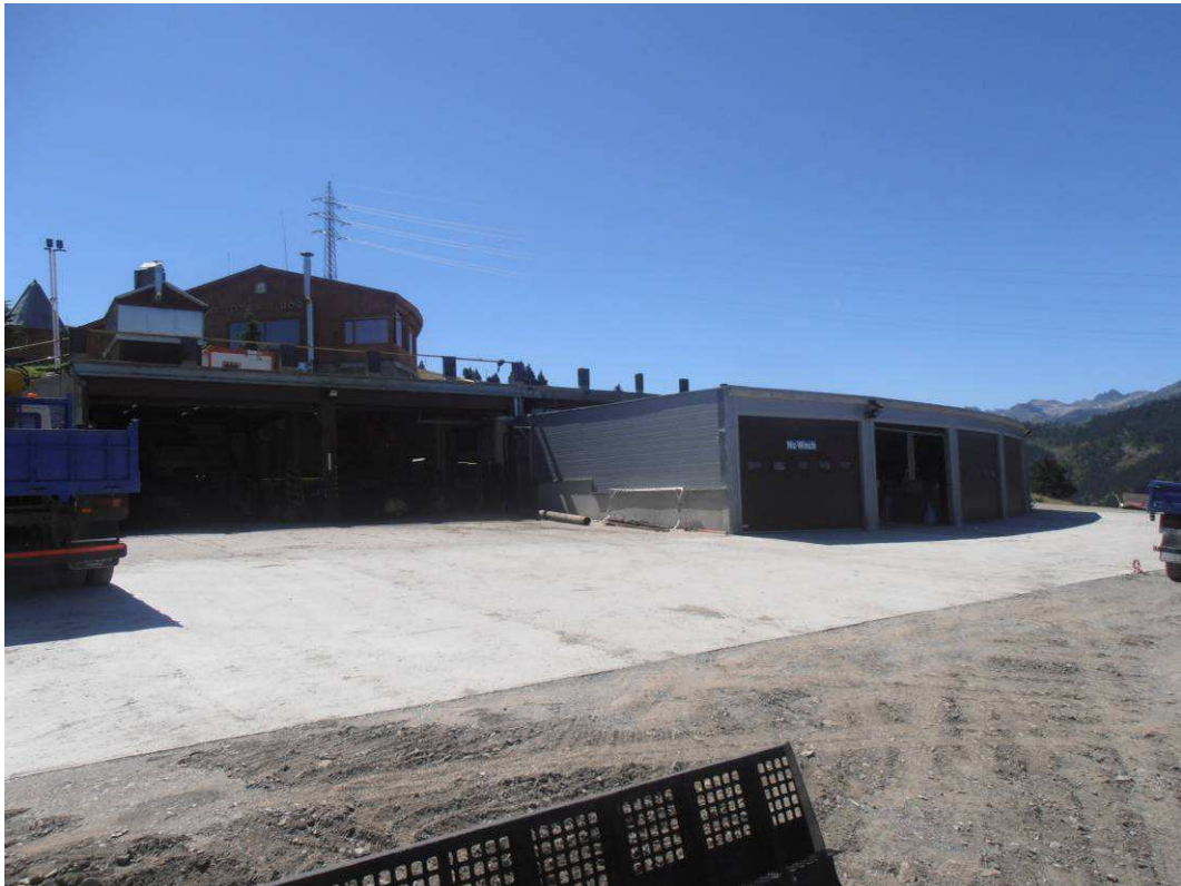
Vista en direcció nord de l'entrada als 5 boxes, edifici que s'ha ampliat a partir del taller existent.
