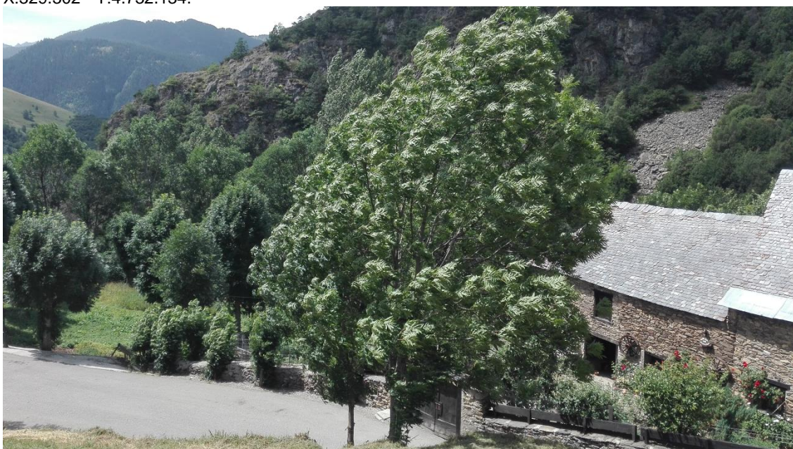
Figura 56. façana lateral de la edificació, vista des de la carretera d'accés i en direcció cap al sud (final de la vall). S'evidencia com la massa arbòria dificulta la visibilitat de l'edificació. Coordenades UTM: X:329.302 - Y:4.732.134.
