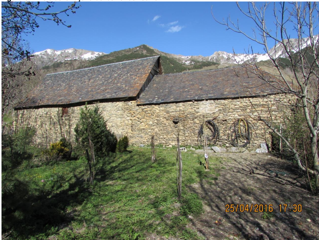
Figura 51. Visió de la façana del darrer de l'edifici.
