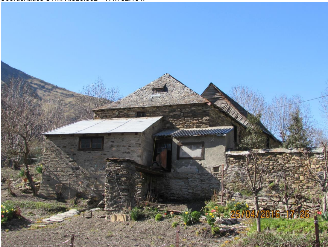
Figura 58. Vista en detall de l'edificació des del sud, des de la carretera d'accés a Bagergue. Coordenades UTM: X:329.302 - Y:4.732.134.
