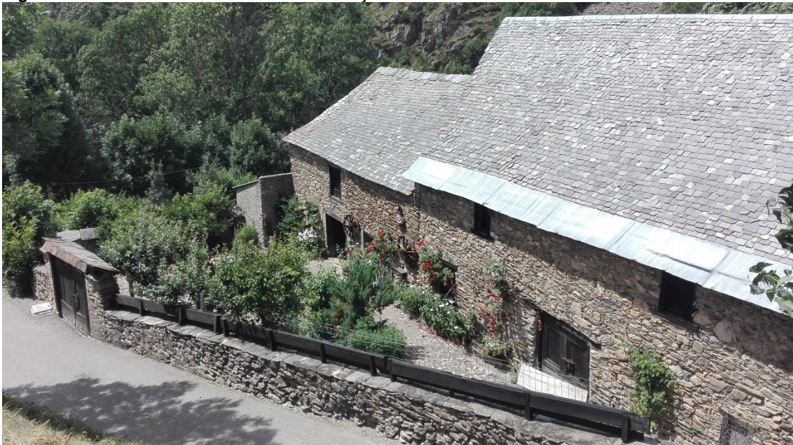
Figura 63. Vista des de la carretera d'accés. Façana davantera de l'edifici.
