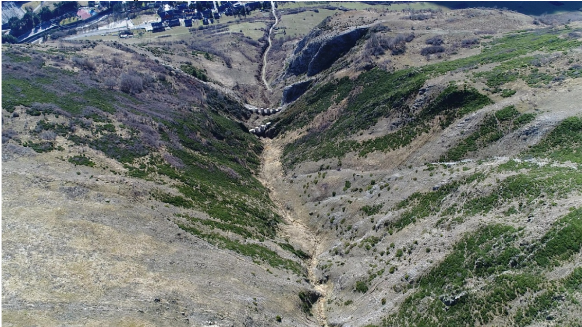
Imatge 3: vista de la zona aigües amunt dels dics, i on s'aprecia l'alineació de desprendiments de blocs.
