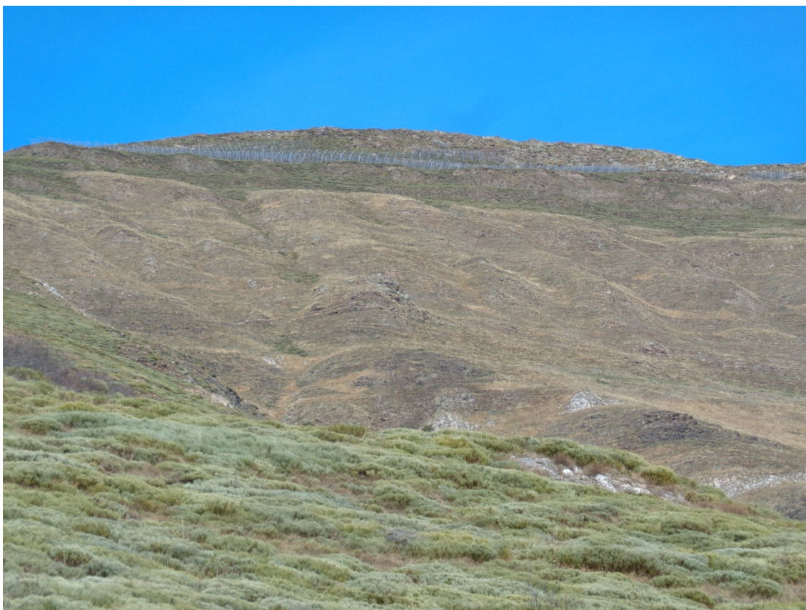
Vista de les proteccions per estabilitzar el mantell nival en capçalera del barranc des Artigues
