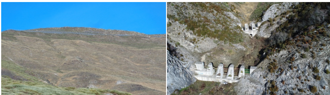
Imatges 7 i 8: a l'esquerra es veuen les proteccions per estabilitzar el matell nival a la part alta del Barranc des Artigues i a la dreta els dos dics existents per aturar o disminuir l'energia d'una possible allau.
