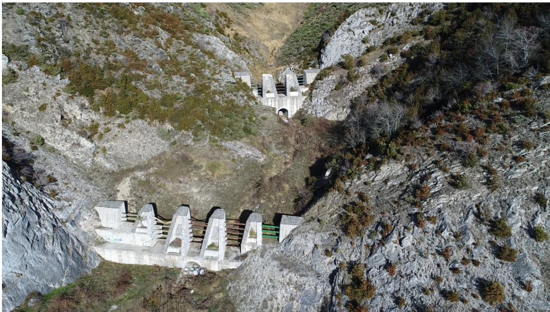
Vista dels dics antiavalles del barranc des Artigues
