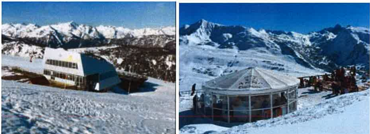
Imatge 21. Imatge comparativa de l'edificació actual i de la infraestructura que es vol implantar en el seu lloc.
