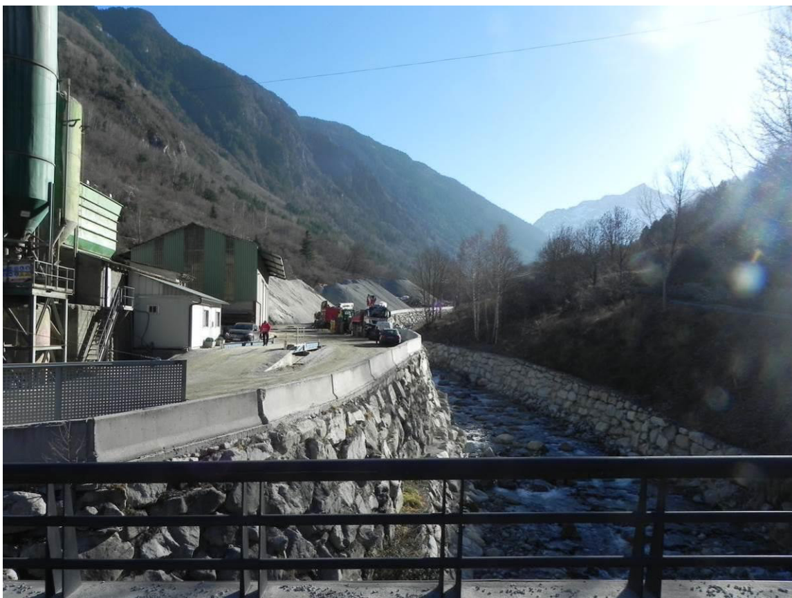
Foto 1. Vista de l'àmbit en sentit S-N, des del pont que hi dóna entrada amb les sitges a esquerra a primer pla, la nau existent al centre, alguns acopis al fons, i a l'esquerra, el riu Valarties, conduït en obra d'escollera. Al fons, a la dreta, el cim del Montardo (2833 m), i a l'extrem dret, pel marge esquerre del riu, la pista de Valarties- Aiguamog.
