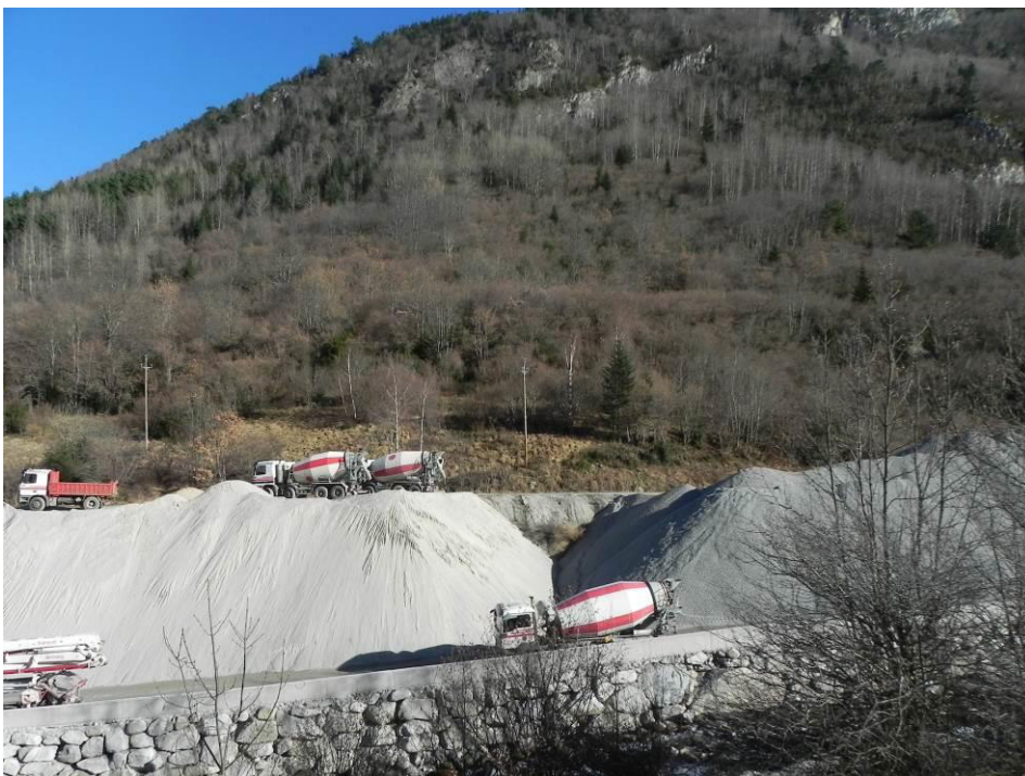
Foto 6. Vista dels abassegament de graves i àrids des de la pista forestal de Valarties-Aiguamog, amb l'escollera del riu a primer terme. S'observa el muret que protegeix el vial interior del riu. Al darrere, al vessant de la muntanya, s'observa alguns prats de dall abandonats, peus d'avet, de bedoll i principalment, la fageda ( Fagus sylvatica ).
