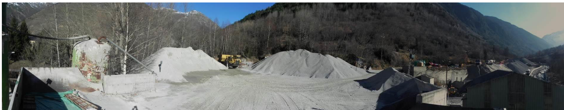
Foto 4. Vista de detall de l'àmbit des del replà superior de l'àmbit, en sentit N-SE. A esquerra, s'observa la sitja de ciment, la zona d'acopi i a dreta, una part de la nau existent, i la vall del riu Valarties que prossegueix vers el S amb el cim del Montardo a la capçalera.
