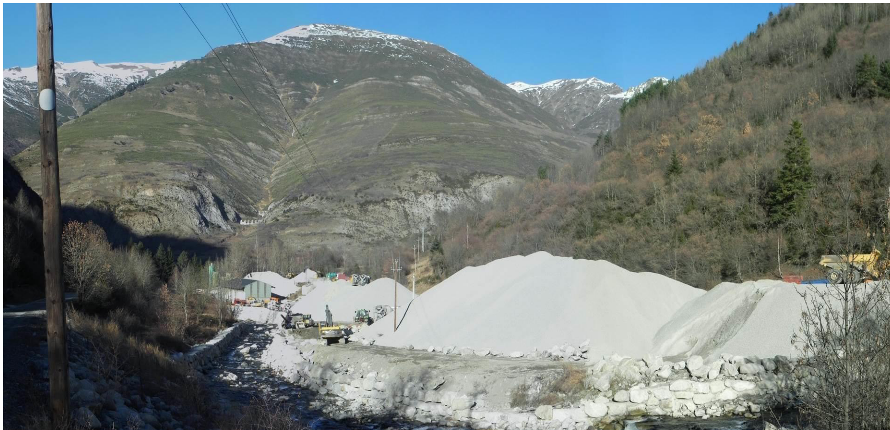
Foto 6. Vista general de l'àmbit en sentit S-N, des de la pista Valarties- Aiguamog, amb el riu a primer terme, els acopis de graves situats a la part alta, ja al límit S de l'àmbit.
