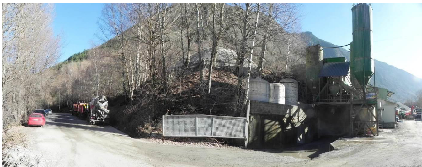
Foto 1. Vista de detall de l'àmbit en sentit N-SE. A l'esquerra, s'observa l'accés per la pista asfaltada procedent de la carretera C-28, al centre la tanca d'accés i a la dreta, les sitges de ciment de la planta per a la producció de formigó i el vial d'accés.
