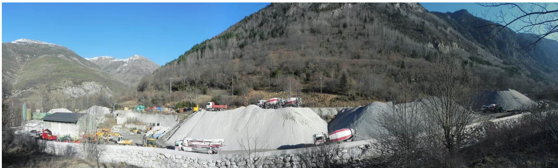
Foto 5. Vista general de l'àmbit en sentit O-E, des de la pista Valarties- Aiguamog, amb el riu a primer terme, els acopis de graves al llarg de tota la meitat S de l'àmbit. En aquesta foto s'observa clarament els dos replans del sector comunicats pel vial que els circumvala.
