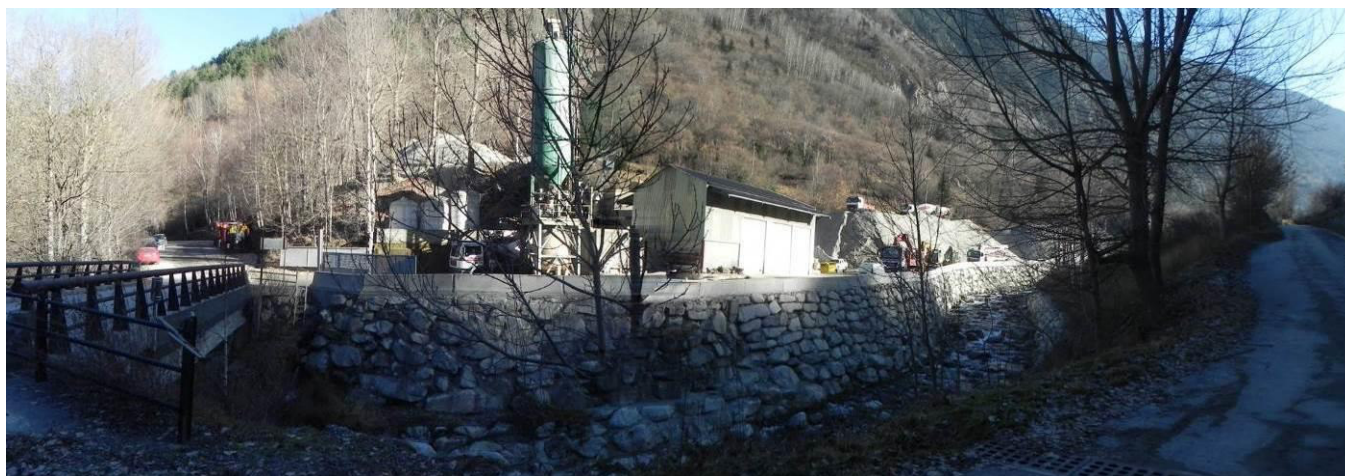
Foto 2. L'àmbit en sentit O-E, amb l'accés pel pont de Valarties, vista general de la planta amb el riu a primer terme, i a dreta, la pista Valarties-Aiguamog.
