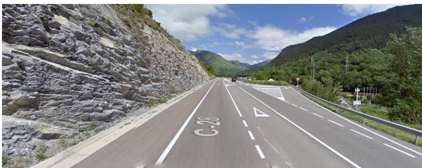
Foto 12. La carretera C-28 en sentit O-E, just abans d'arribar al desviament des d'on arrenca el vial asfaltat que duu a l'àmbit. La carretera disposa de carril d'incorporació en ambdós sentits.
