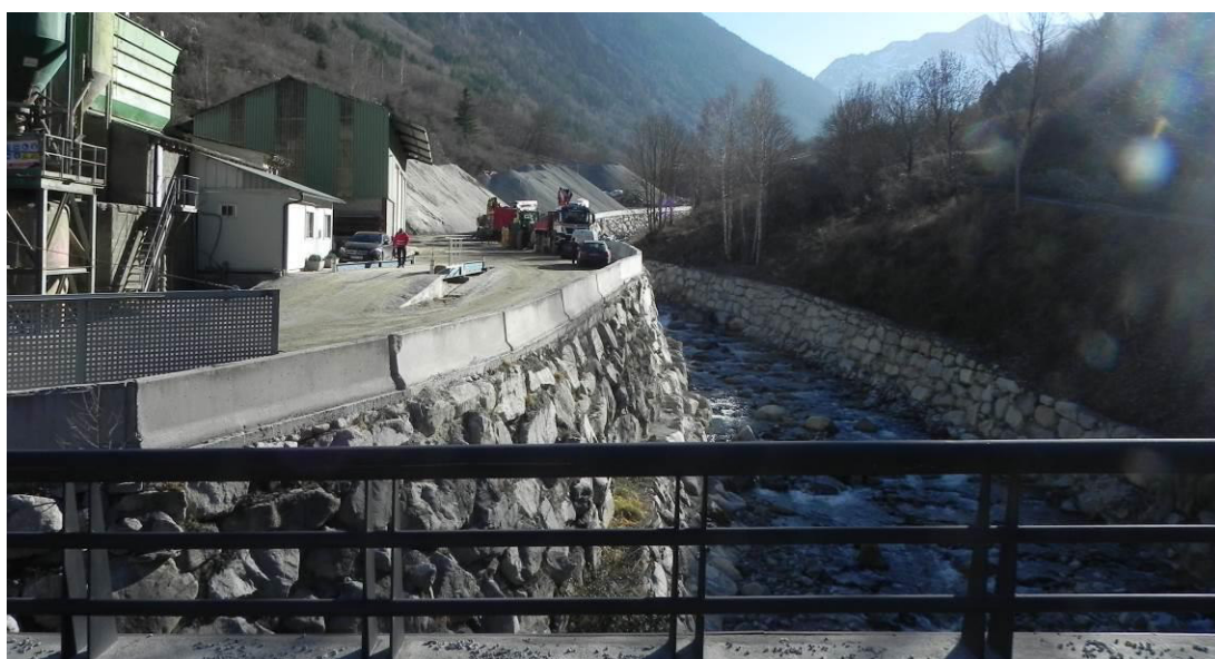
Foto 15. El riu Valarties, en sentit N-S, amb l'escullera de protecció que es va construir fa alguns anys. S'observa que la diferència aproximada de cota entre la llera i l'àmbit és de 5 m. s'observa també la protecció sobre la rasant de l'àmbit amb peces prefabricades tipus New Jersey.
