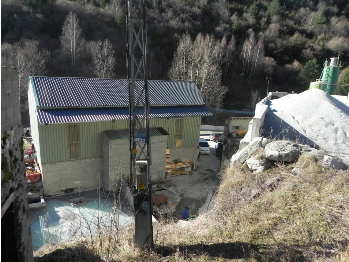
Foto 8. Vista de l'àmbit en sentit E-O, des de l'espai on es faria la nova edificació. En aquesta foto s'observa el centre actual i la pista Valarties-Alguamog al fons de la imatge.
