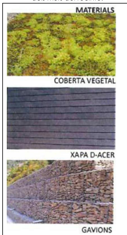
Figura 8. Materials i textures de la coberta vegetal, paraments de l'edifici i gabions de contenció dels murs del recinte.
