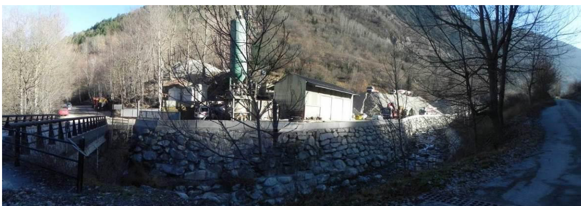
Foto 5. L'àmbit en sentit O-E, amb l'accés pel pont de Valarties, vista general de la planta amb el riu a primer terme, i a dreta, la pista Valarties-Aiguamog.
