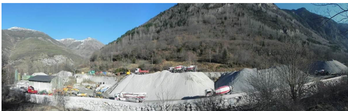
Foto 4. Vista general de l'àmbit en sentit O-E, des de la pista Valarties- Aiguamog, amb el riu a primer terme, els acopis de graves al llarg de tota la meitat S de l'àmbit. En aquesta foto s'observa clarament els dos replans del sector comunicats pel vial que els circumvala.
