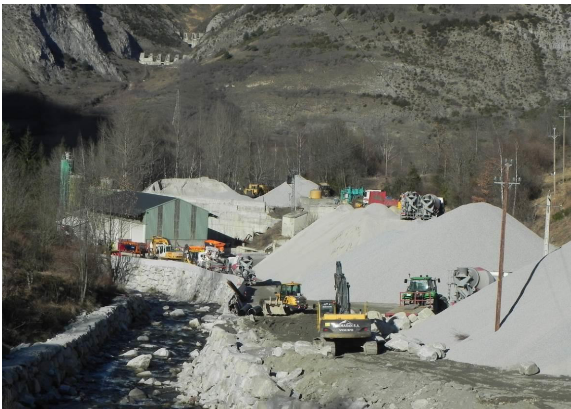
Foto 7. Àmbit des del centre de l'àmbit, en sentit S-N. A esquerra, s'observa el riu amb un muret de 1 metre consistent en una filera de New Jersey, maquinària aparcada, la nau existent i a dreta, l'espai a on es faria la nova edificació aprofitant el desnivell amb el replà superior.
