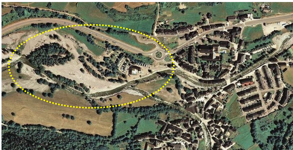
Imatge 12. Enclavament del càmping Era Yerla, a la part SO del nucli d'Arties, al costat de la confluència dues conques hidrogràfiques, la del Noguera Pallaresa i la de la Garona. (Imatge posterior a les riudes de 2013)
