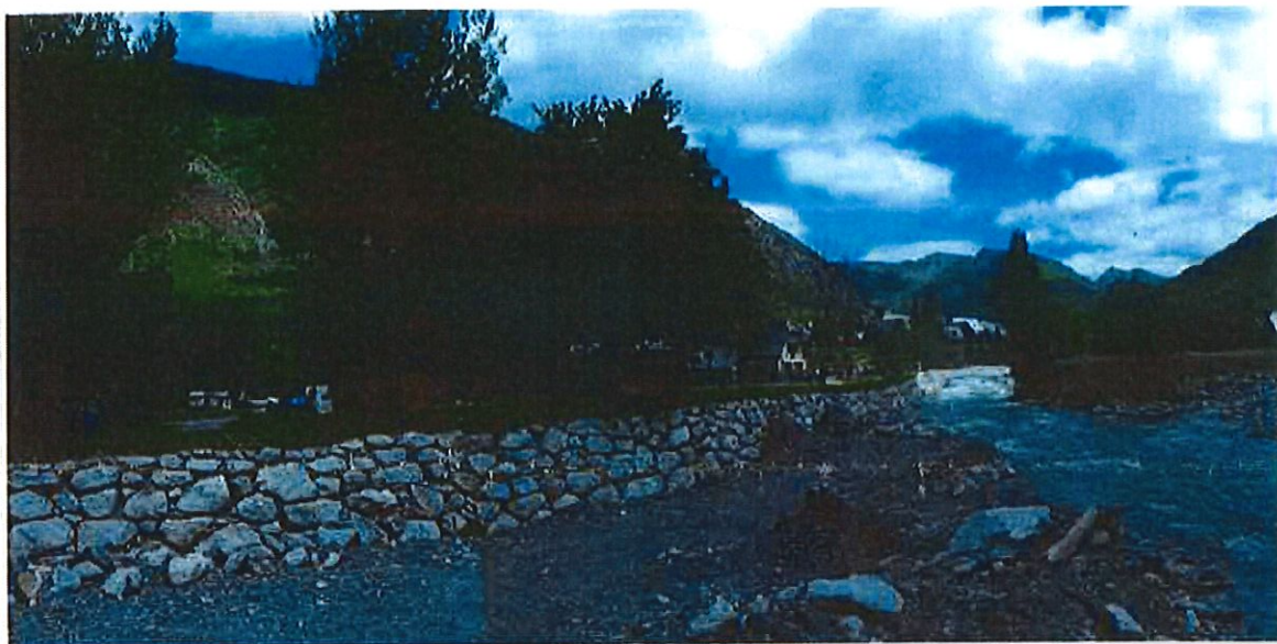
Imatge del càmping, en sentit S-NE, amb l'escullera de protecció que es va construir respecte el riu Garona. Tot i això, arran de les inundacions de 18/06/2013, el riu va derivar el seu curs vers la dreta de la imatge, just allà on es forma l'aiguabarreig amb el riu Valarties que hi tributa per l'extrem dret. Font ISAP
