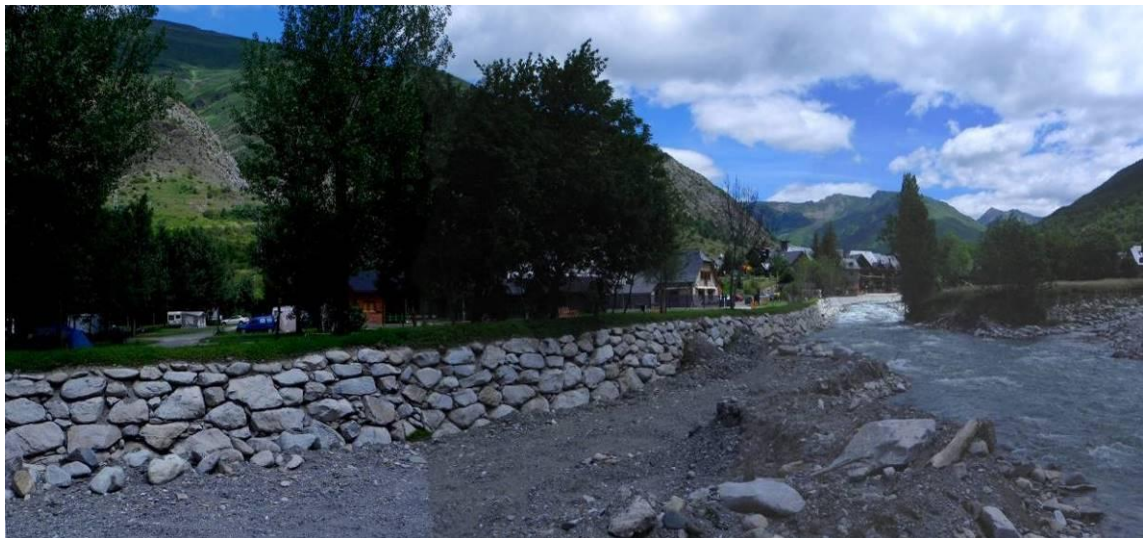
Imatge 29. Imatge del càmping, en sentit S-NE, amb l'escullera de protecció que es va construir respecte el riu Garona. Tot i això, arran de les inundacions de 18/06/2013, el riu va derivar el seu curs vers la dreta de la imatge, just allà on es forma l'aiguabarreig amb el riu Valarties que hi tributa per l'extrem dret.
