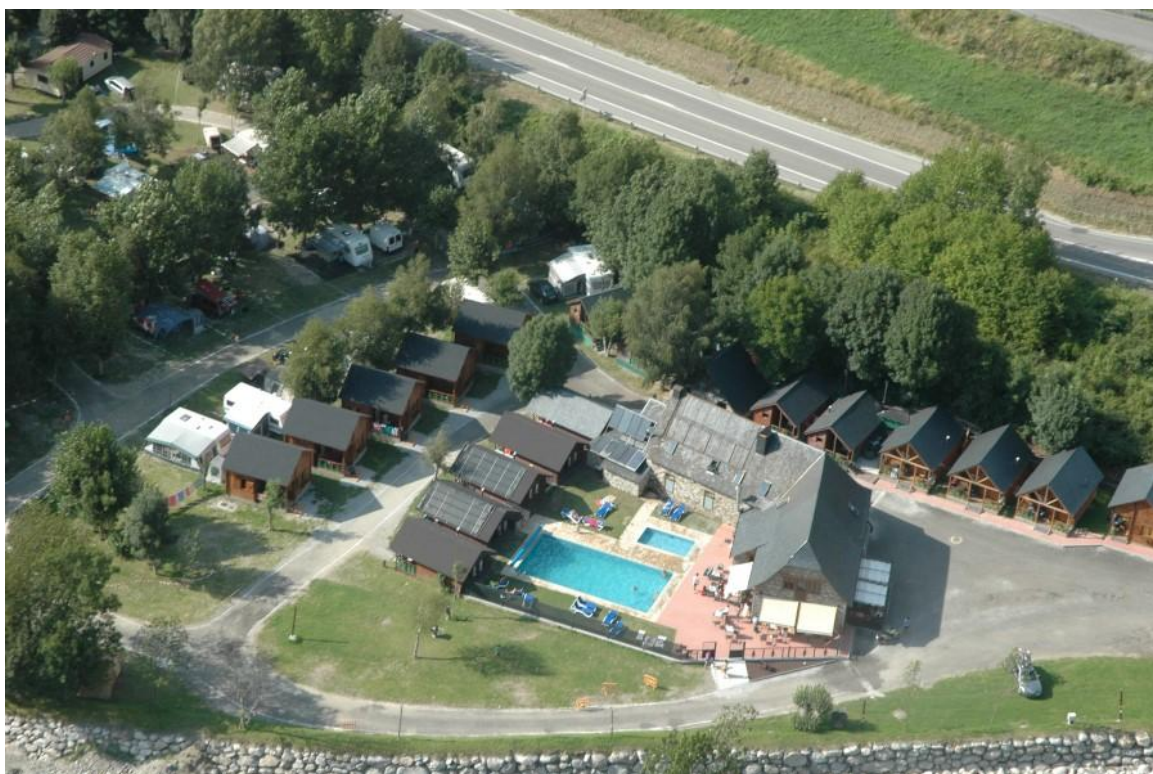
Imatge 0. Vista de l'àmbit en sentit S-N, zona de serveis i zona de bungalows Font: CAMPING ERA YERLA SCP / PAMPOLS ARQUITECTE SLP
