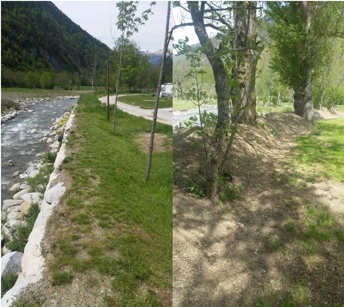
Imatge 21. Vista de la mota de terra naturalitzada a l'alçada d'on s'inicia l'escollera, i vista de la mateixa mota aigües avall.
