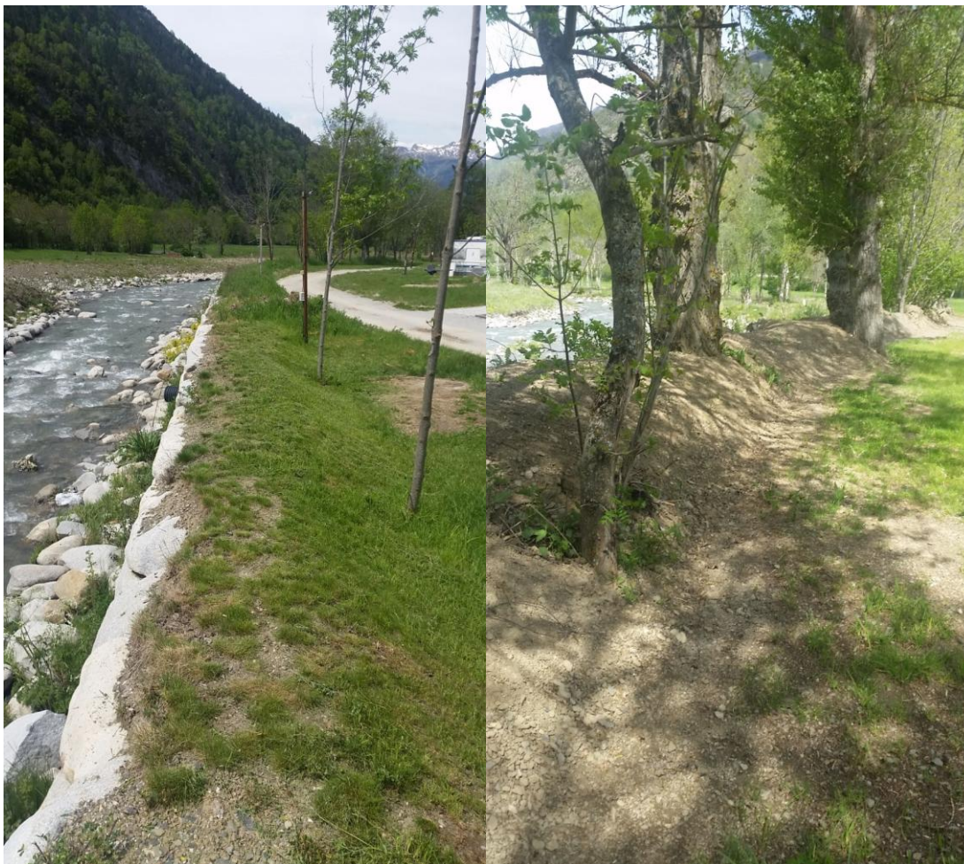
Foto 12 i 13. Vista de la mota de terra naturalitzada a l'alçada d'on s'inicia l'escollera, i vista de la mateixa mota aigües avall.
