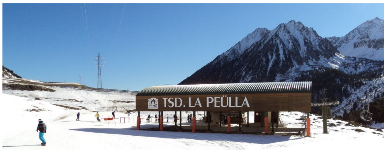
Estació d'embarcament de la Peülla
