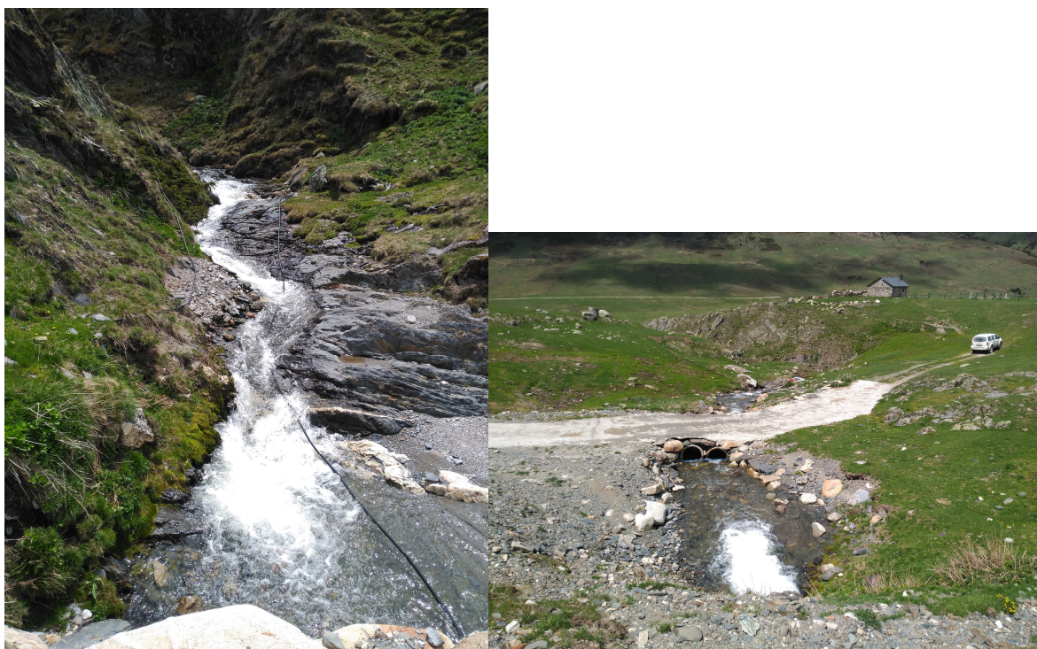
Vista del paso sobre el río Beret hacia aguas arriba (izqda) y hacia aguas abajo (dcha)
