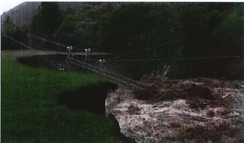
Detalle de erosión de las márgenes del río
