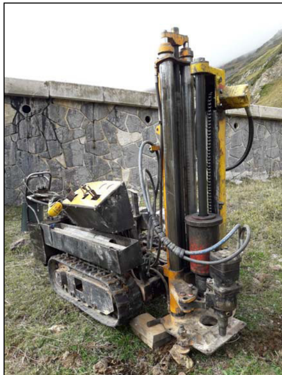
Fotografia 1. Detall de la màquina realitzant l'assaig de penetració DPSH.
