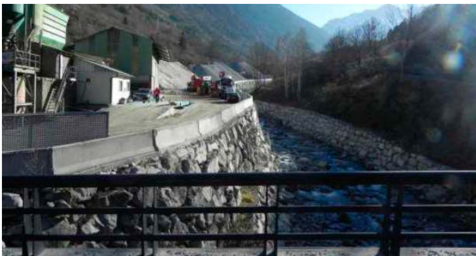
El riu Valarties, en sentit N-S, amb l'escullera de protecció que es va construir fa alguns anys. S'observa que la diferència aproximada de cota entre la llera i l'àmbit és de 5 m. s'observa també la protecció sobre la rasant de l'àmbit amb peces prefabricades tipus New Jersey.
