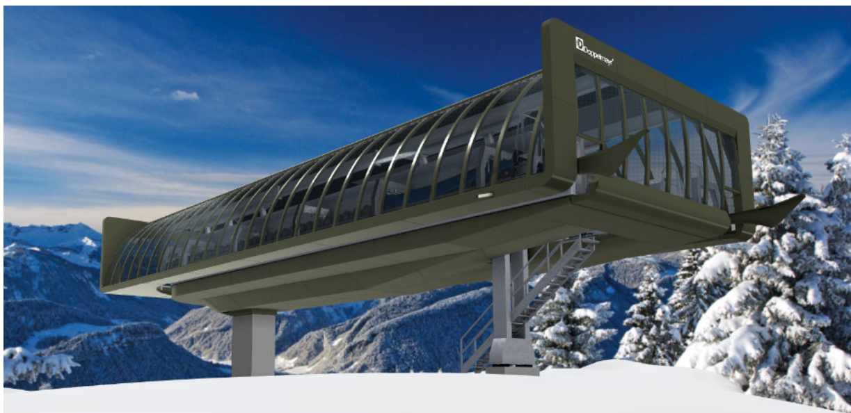
Figura 3.7. Imatge de l'estació tipus que es col·locarà tant a la part inferior com superior del TSD Clot der Os.
