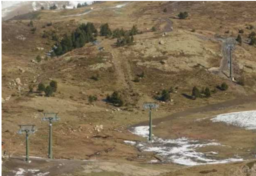
Imatge 4.10. Exemples dels acabats utilitzats en les pilones i en les instal·lacions auxiliars.
