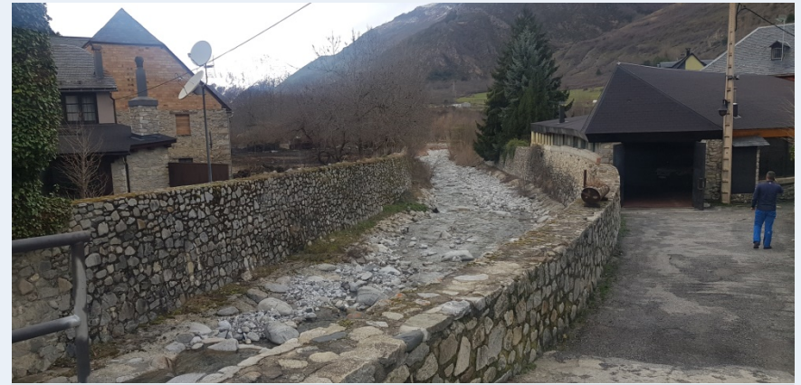
F39. Río Valarties. Aguas abajo del puente
