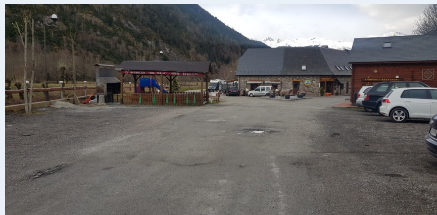
F4. Murete camping Era Yerla.
