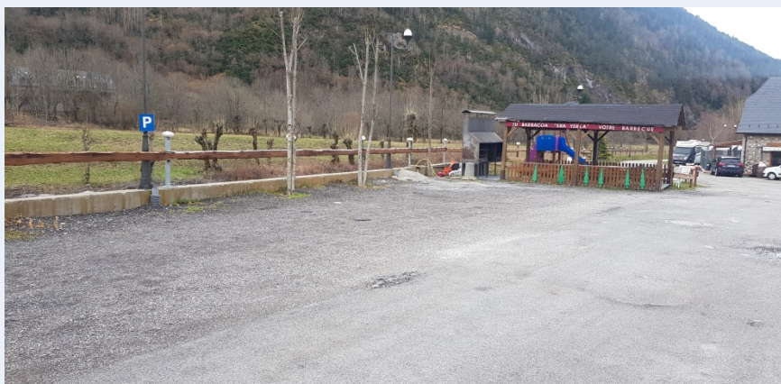
F3. Murete camping Era Yerla.
