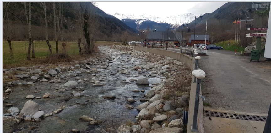
F6. Muro camping Era Yerla. Vista hacia aguas abajo
