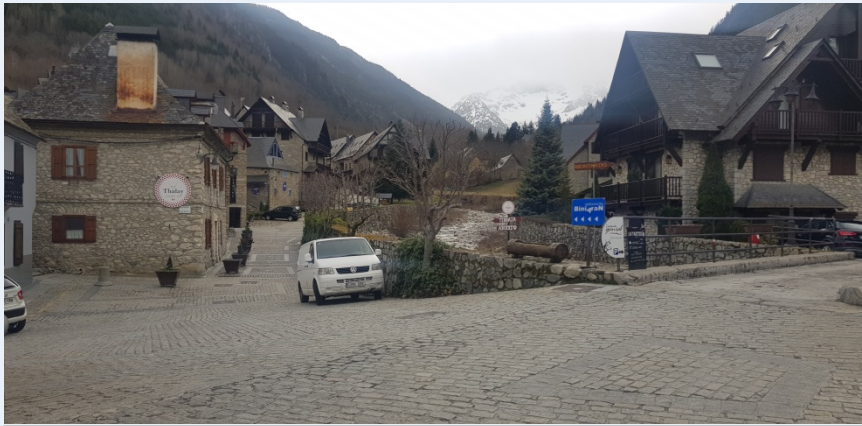
F38. Puente río Valarties. Vista hacia aguas abajo
