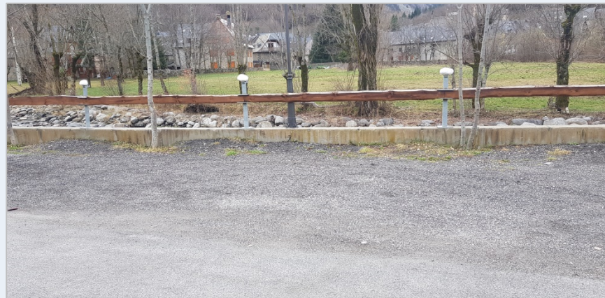
F2. Murete camping Era Yerla.
