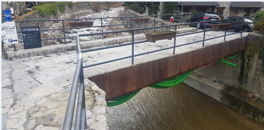
F40. Puente río Valrties. Vista hacia aguas abajo
