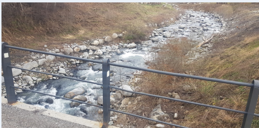
F35. Puente sobre río Garona. Vista hacia aguas arriba
