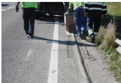
Procés de rebliment de la rasa amb morter.
