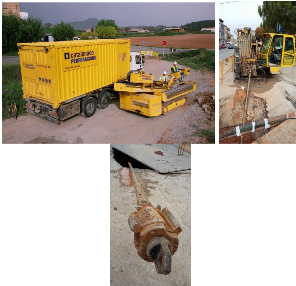
Detalls Maquinaria Perforació Empresa Catalana perforacions
