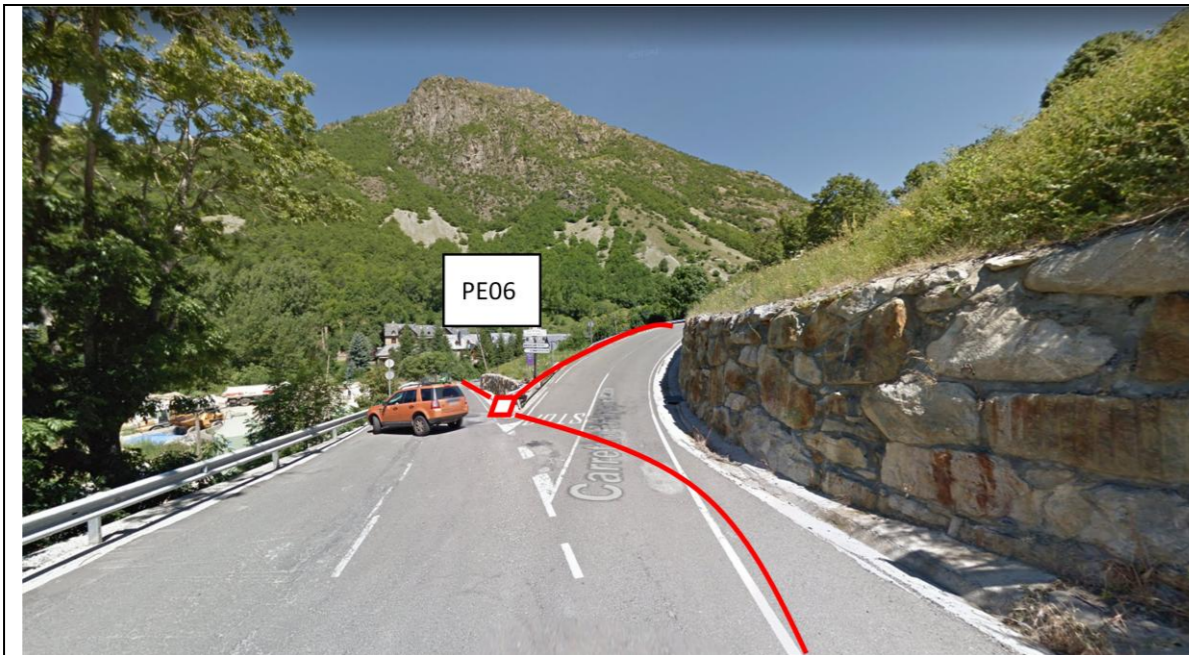
Microrasa per calçada/cuneta per la carretera de Bagergue (tram no urbà), bifurcació cap al nucli de Unha.
