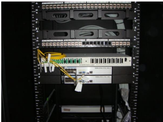
Exemples d'instal·lació de Repartidor de Fibra Òptica
