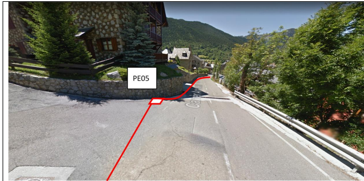
Microrasa per calçada per el carrer des Arroquets (nucli de Salardú), inici de la microrasa per la carretera de Bagergue.
