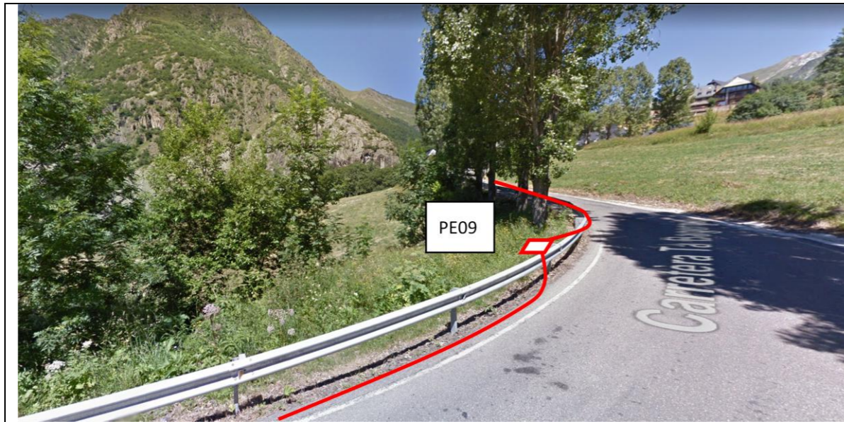
Microrasa per calçada/cuneta per la carretera de Bagergue (tram no urbà).
