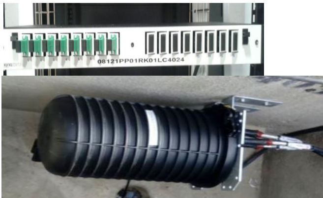
Exemple d'etiquetat de cables, racks, repartidors i caixes d'empuïament.
