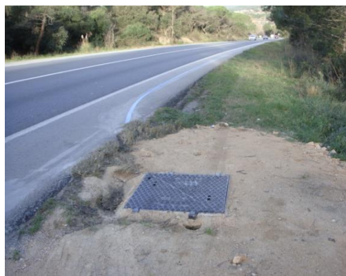
Exemple de l'estat de la canalització acabada
