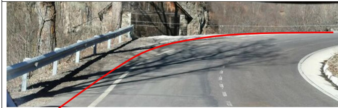
Microrasa per calçada/cuneta per la carretera de Bagergue (tram no urbà).
