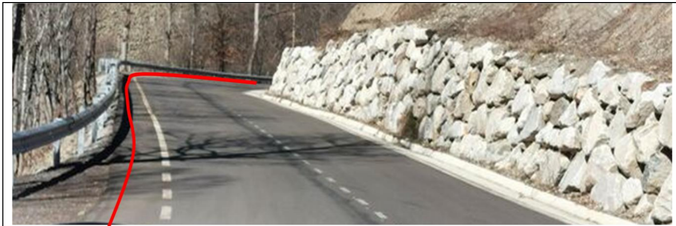
Microrasa per calçada/cuneta per la carretera de Bagergue (tram no urbà).
