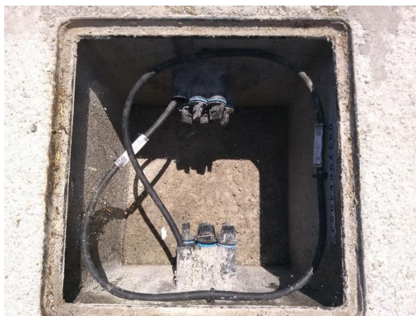
Exemple de pas de cable per pericó
