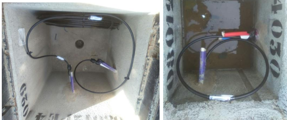
Exemples Terminació microductes en pericó
