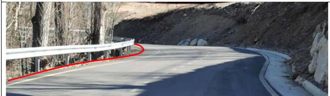
Microrasa per calçada/cuneta per la carretera de Bagergue (tram no urbà).
