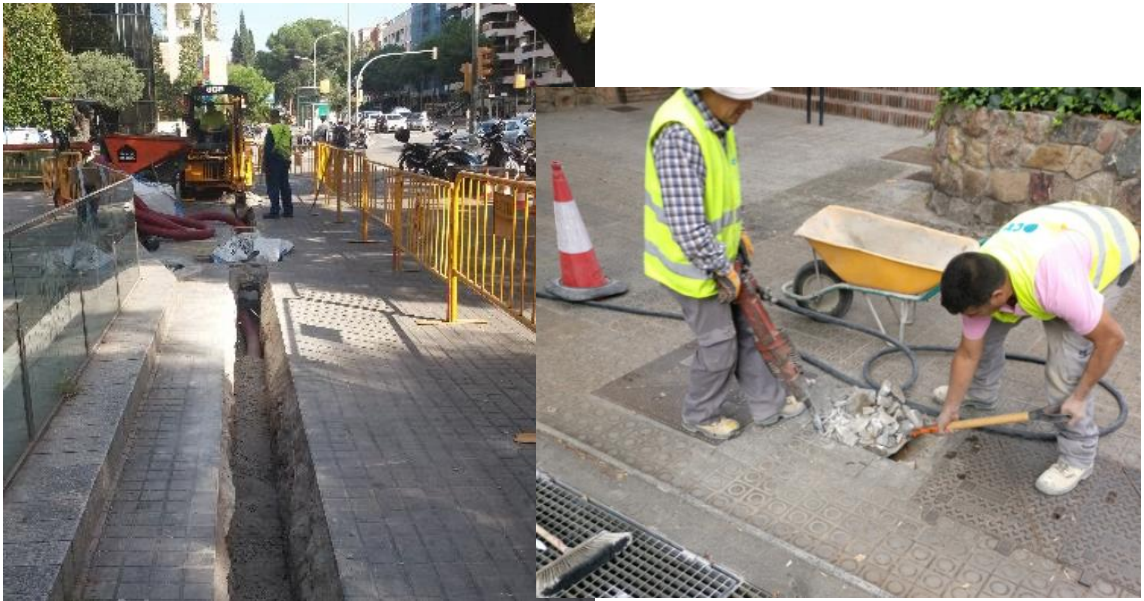
Exemples Canalització Convencional en àmbit municipal.
