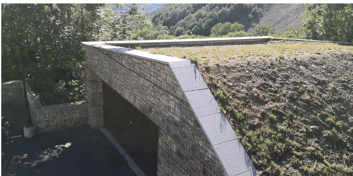
Coberta verda del nou aparcament cobert, vist des de les escales d'accés a l'aparcament.
