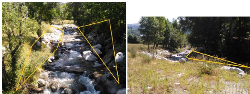
Ampliación del cauce.
