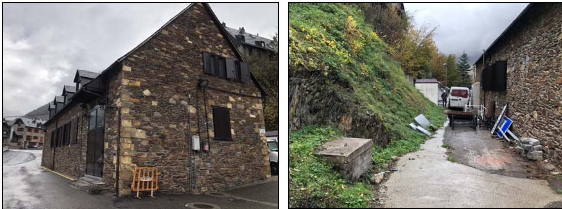
Fotografia 1 i Fotografia 2. Detall de l'edifici i zona on es realitzarà l'ampliació.
