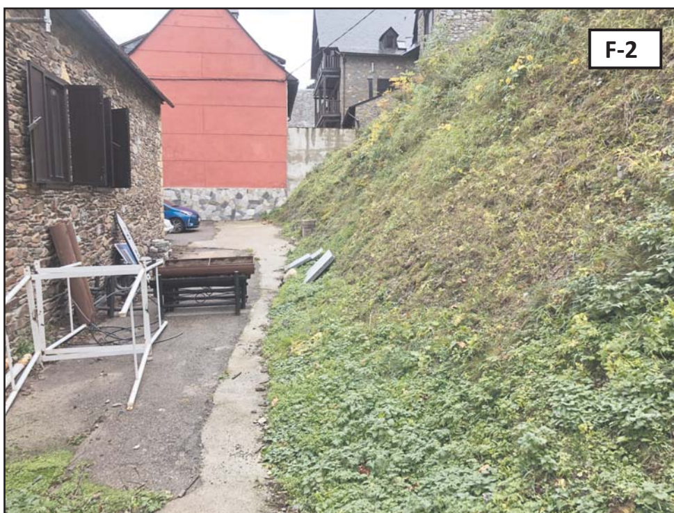
Fotografies 1 i 2: Vista de la parcel·la objecte d'estudi, amb l'edifici a ampliar i la zona on s'ubicarà l'ampliació.
