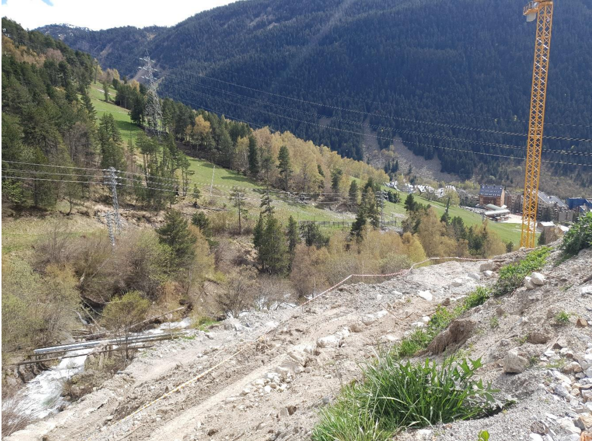
Imagen 6. Fotografía des del Sector Urbanístico PE-5, con vistas al cauce del río Malo Fuente: Pàmpols Arquitecte SLP
