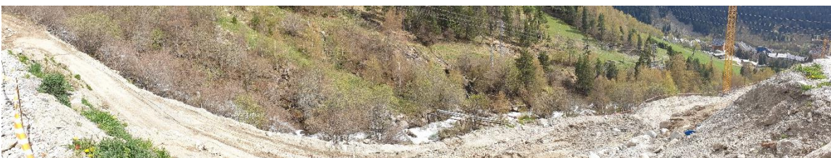
Imagen 7. Fotografía panorámica des del Sector Urbanístico PE-5, con vistas al cauce del río Malo Fuente: Pàmpols Arquitecte SLP
