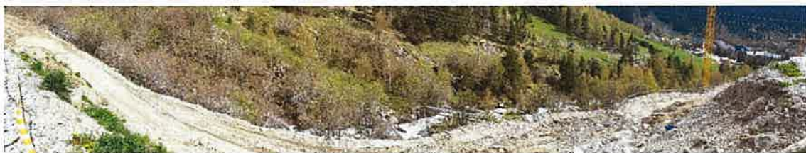
Imagen 7. Fotografía panorámica des del Sector Urbanístico PE-5, con vistas al cauce del río Malo Fuente: Pàmpols Arquitecte SLP
