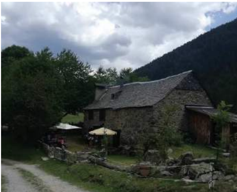
Fotografia 4.11. Visió del conjunt d'edificacions de la Casa Vall, on en la seva part dreta hi ha les restes de l'edificació a reconstruir i rehabilitar.
