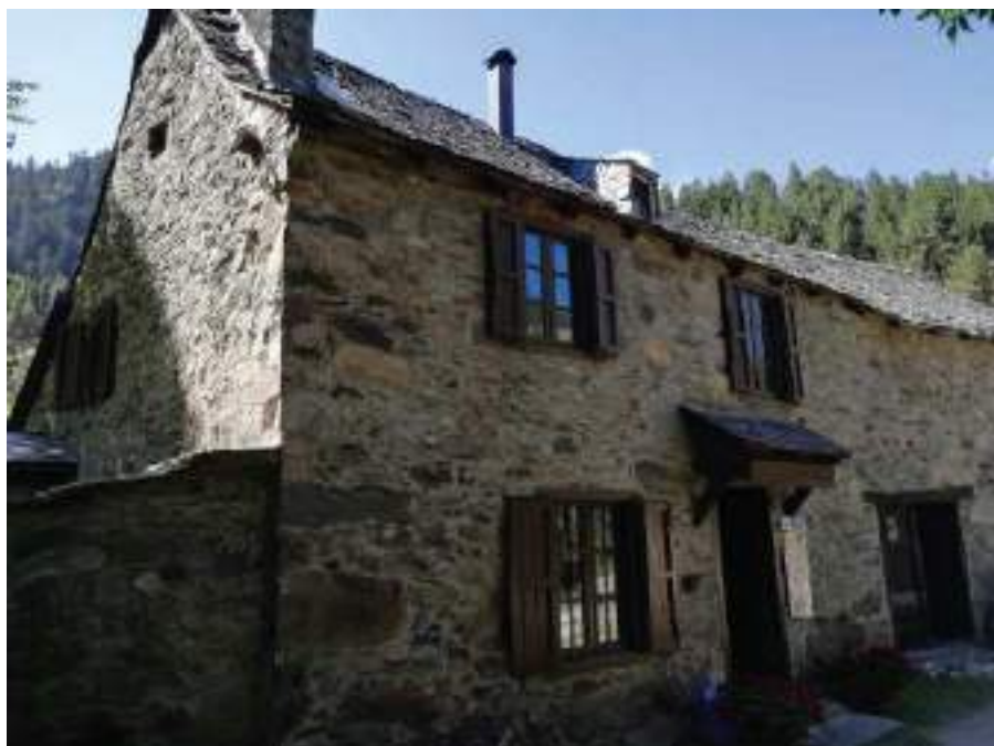
Fotografia 4.10. Visió de la façana principal de la Casa Vall, on es poden observar els materials tradicionals existents.
