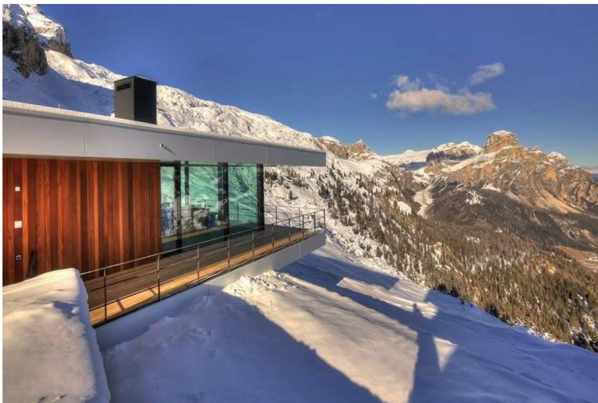
Exemple 5. Acabats exteriors façanes de l'edifici i terrassa-solàrium.
