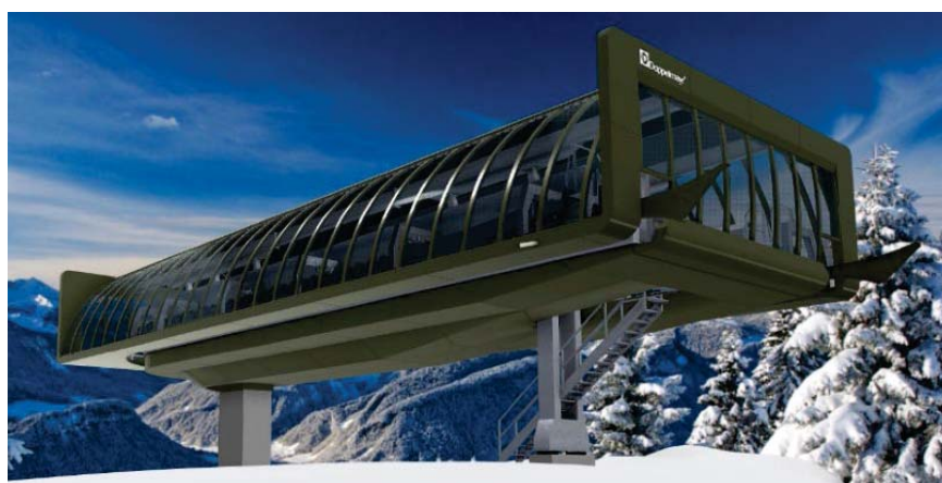
Imatge 45. Proposta estació tipus per estació motriu i de retorn-tensora.. Font: Baqueira Beret.
