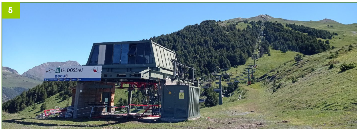
Imatge 44. Estació inferior TS Dossau. Font: Elaboració pròpia.
