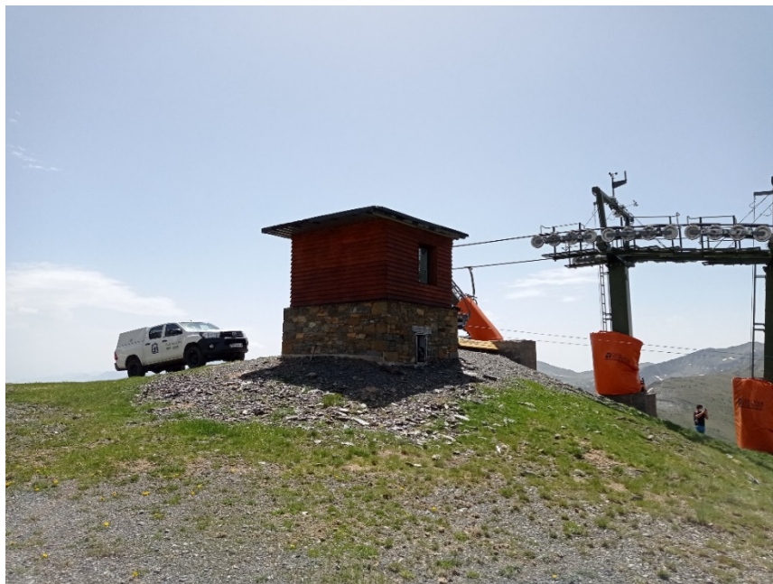
Imatge 52. Situació actual estació motriu. Font: elaboració pròpia.
