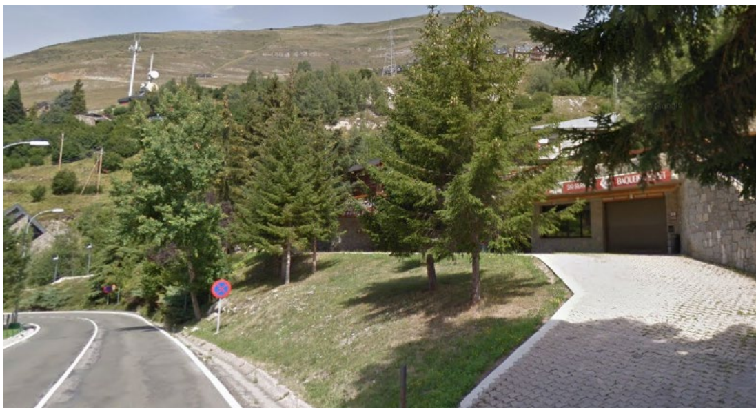
Vista d'un dels accessos a l'edifici des de la C-28.
