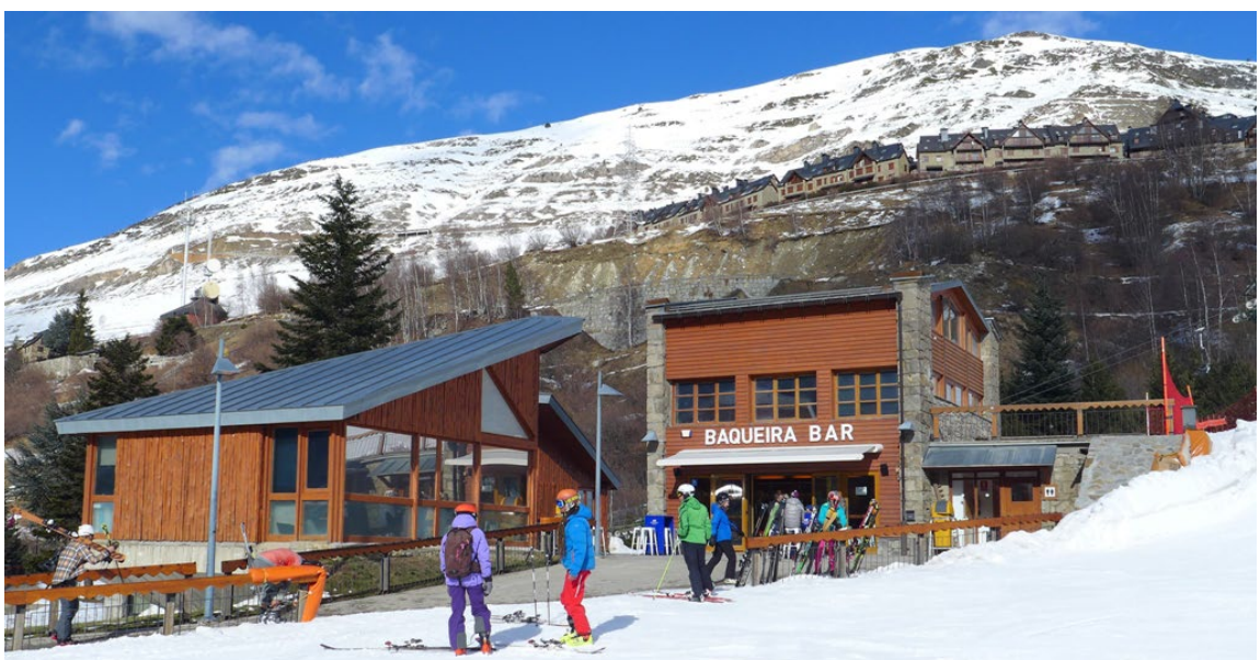
Estat actual, la futura ampliació de l'edifici serà a la part dreta de la imatge sobre la zona dels lavabos.
