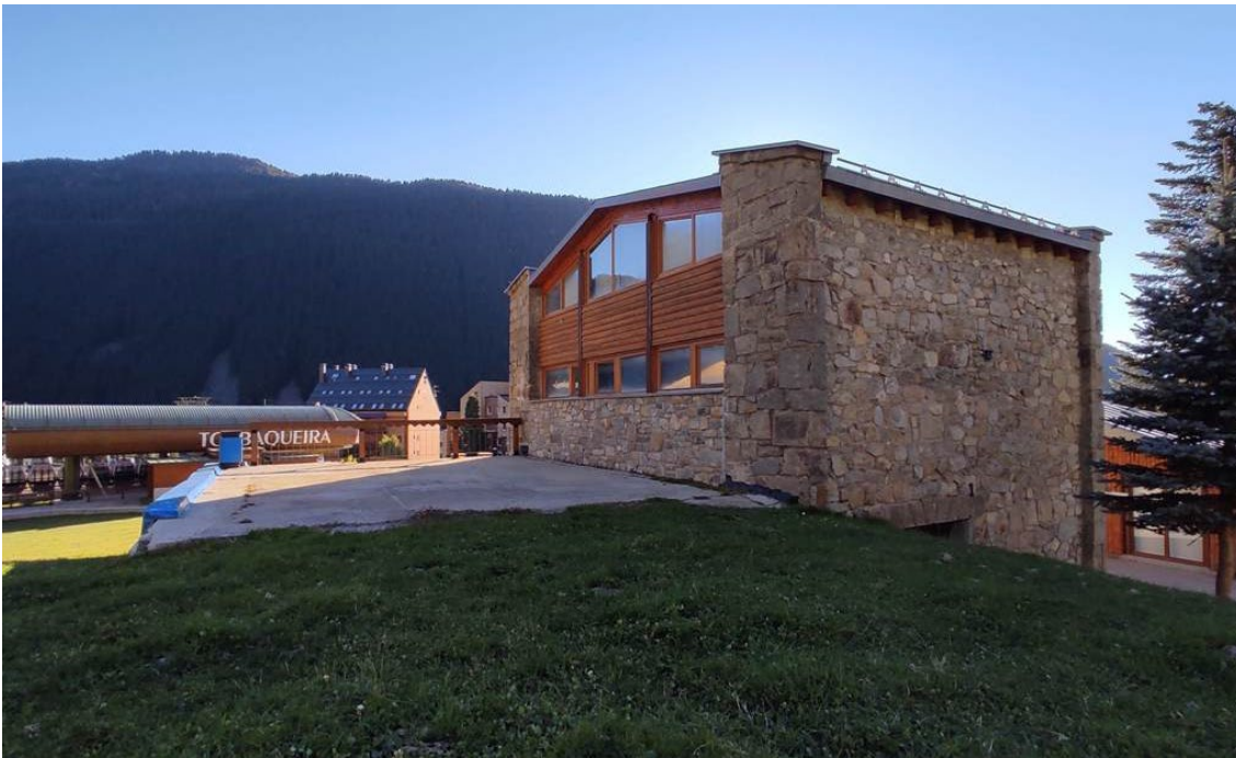
Vista actual on s'observa la zona d'ampliació de l'edifici on s'hi troba una base de formigó.
