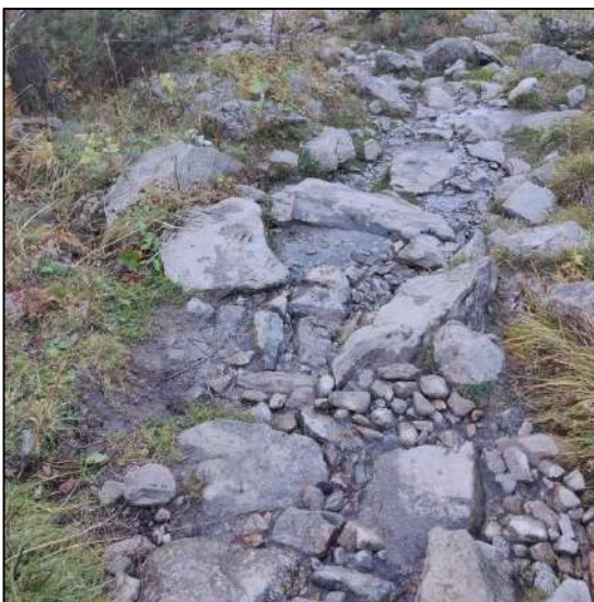
Imatge 3. Camí erosionat i amb aigua canalitzada.
