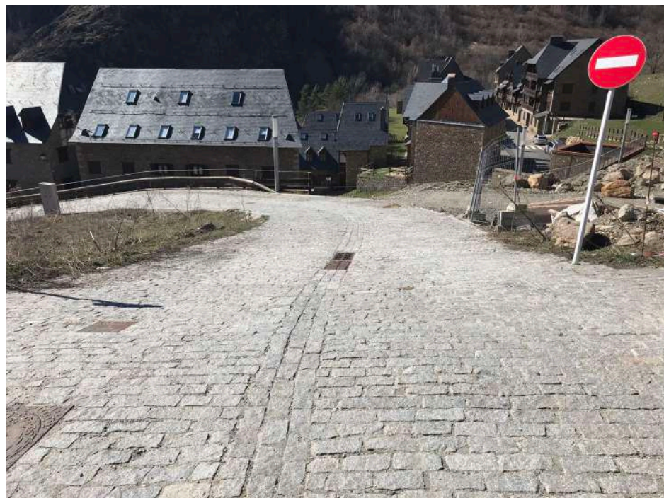
Foto 7 Vials interiors del PP1 pavimentats amb llambordí granític i embornals sobre canaleta central per a recollida d'escorrentia superficial.
