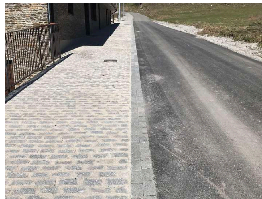
Foto 6 Detall de paviments utilitzats al vial compartit: Vorera i vorada de llambordí granític, enrasat amb la calçada de mescla bituminosa sobre base de tot-ú.
