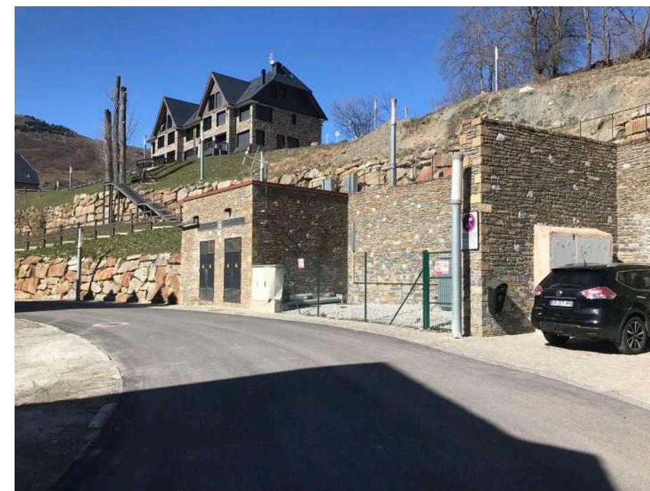
Foto 14 Estació Transformadora de Mitja Tensió, al Camin de Pessòla.
