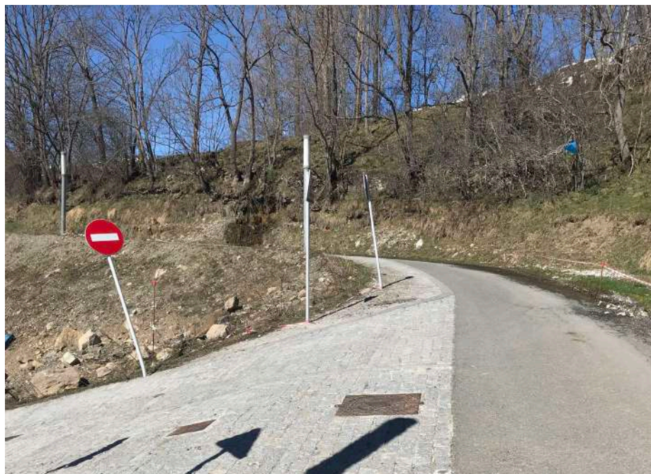
Foto 11 Detalls de la senyalització present a l'àmbit del Pla Parcial 1, amb suports d'alumini circulars de 76mm de diàmetre.
