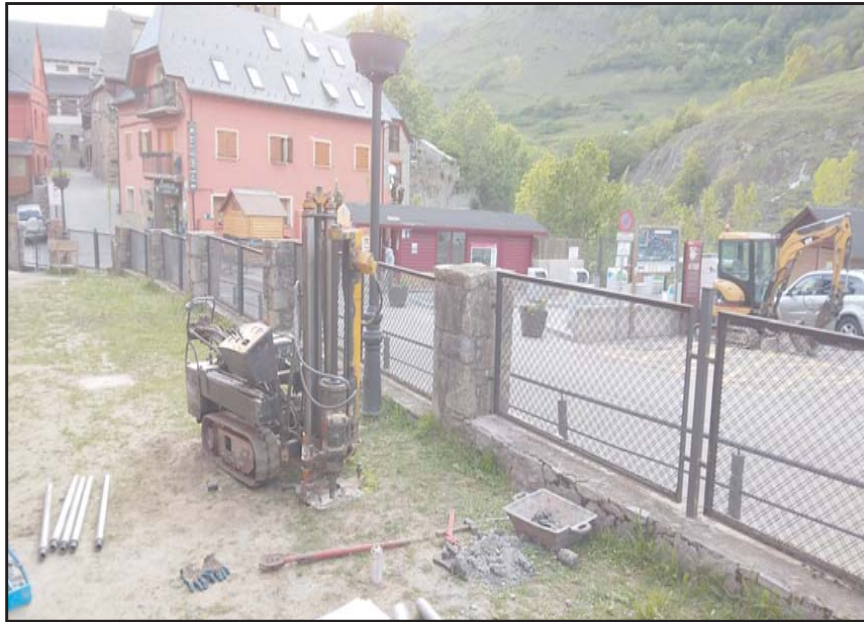
Fotografia 1. Vista general de l'emplaçament del sondeig S-1.
