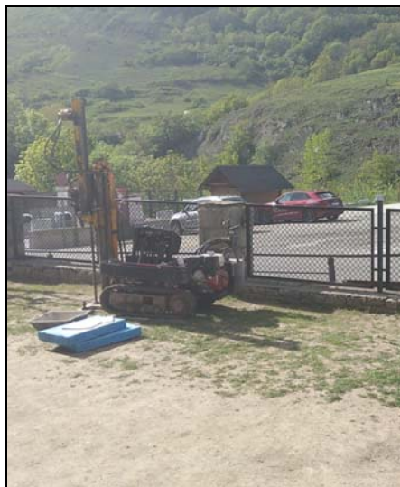
Fotografia 2. Vista de la màquina utilitzada en l'assaig de penetració dinàmica P-1.
