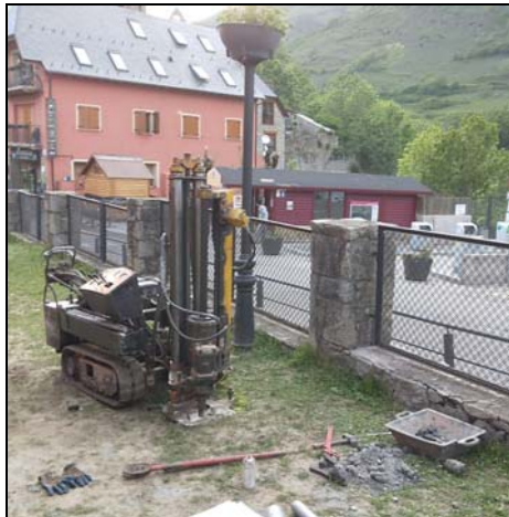
Fotografia 3. Detall de la màquina emplaçada en el solar.
