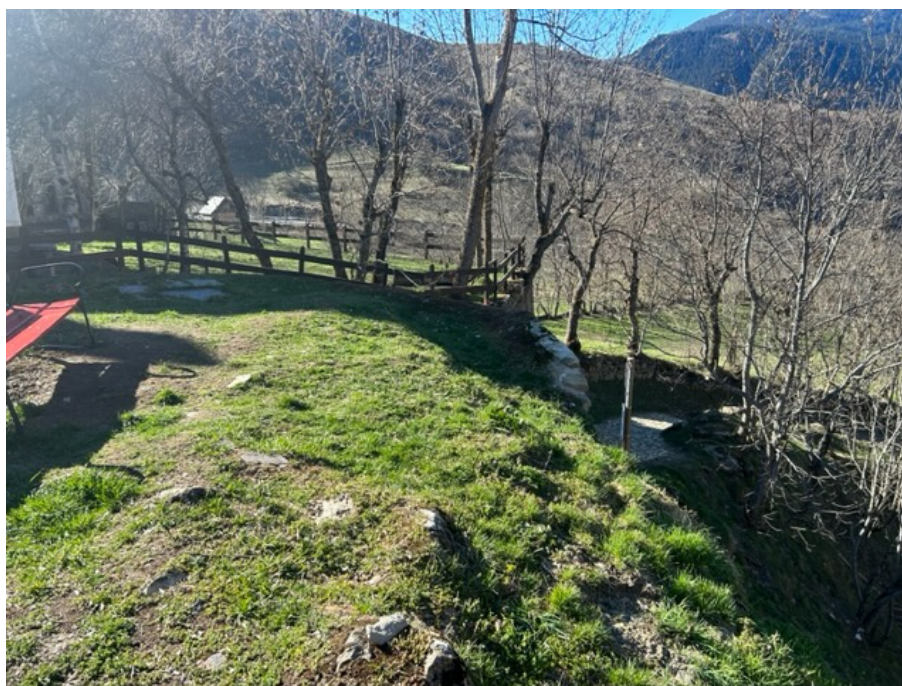
Imatge 5 Estat actual (mur de pedra perimetral)
