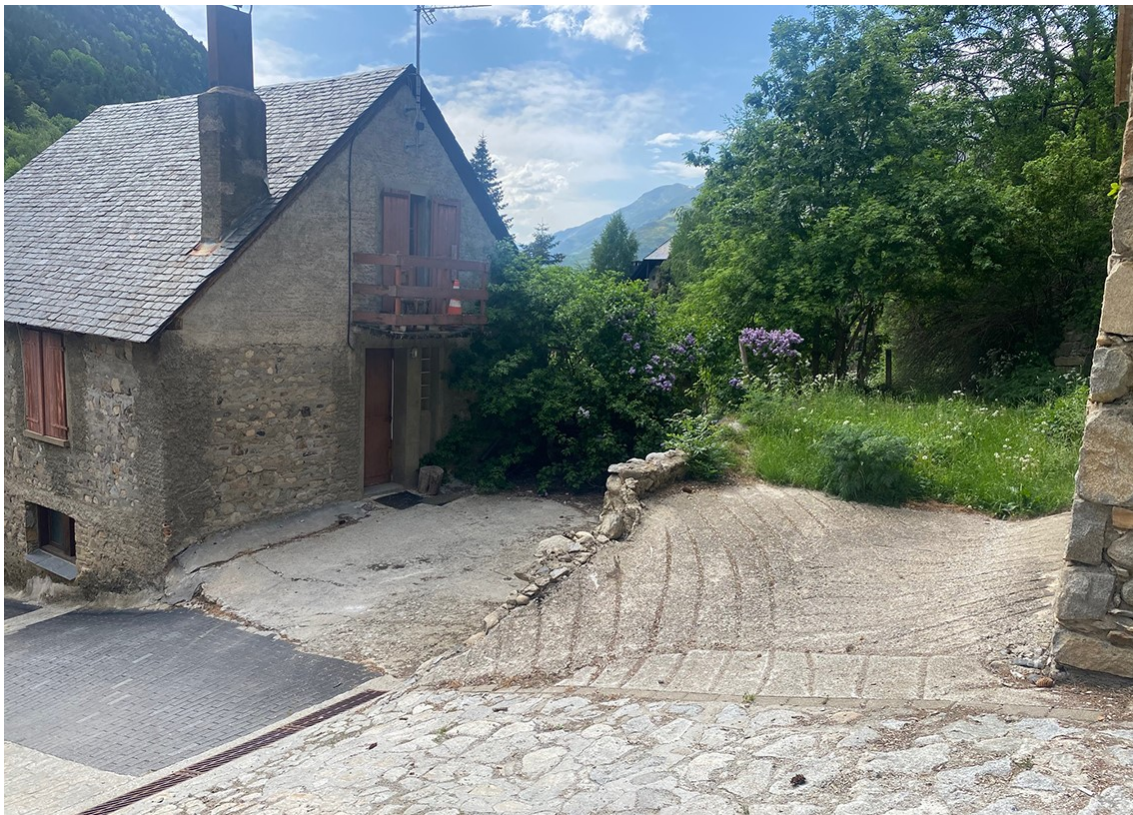
Imatge que permet apreciar la posició real del carrer (en primer terme a la dreta) i l'espai que preveu el planejament (a cota inferior a l'esquerra) que correspon a un pati privat sense sortida ni continuïtat viària més enllà de la finca. Font: pròpia
