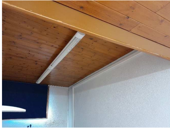
Imatge 6. Imatge de la finestra de la futura sala de cirurgia a tapiar.
