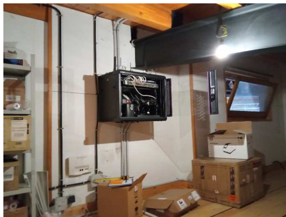
Imatge 13. Fotografia del rack existent en l'altell actual, i que es manté.
