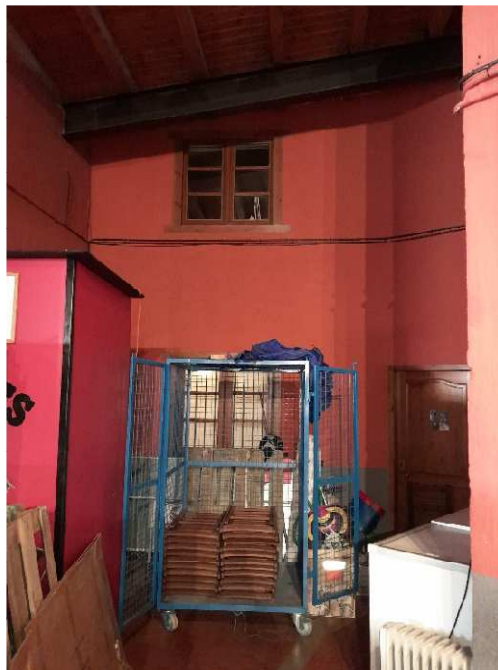
Imatge 8. Vista general de la zona de la sala polivalent que passarà a formar part del dispensari mèdic.
