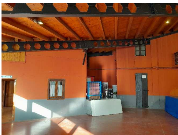
Imatge 5. Imatge des de l'interior de la sala polivalent, en direcció a la finestra de la sala d'infermeria a tapiar.
