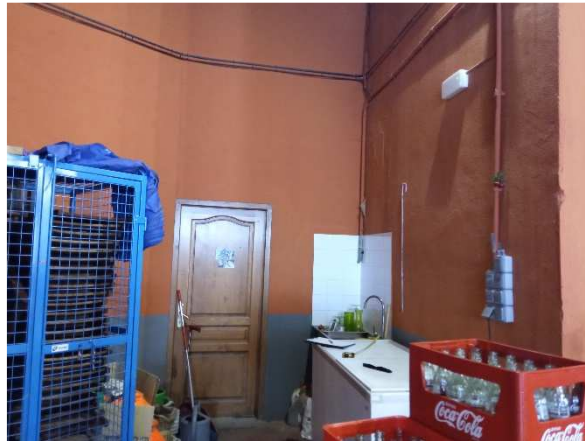
Imatge 7. Imatge de la zona de la sala polivalent que passarà a formar part del dispensari mèdic, on es poden observar les instal·lacions existents.
