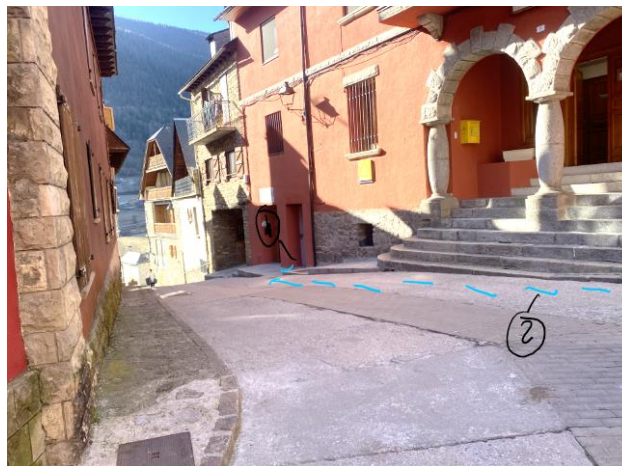
En la Calle Balmes se pide ir con la tubería por el lado de la calle por que se prevé realizar una instalación de tuberías para poder deshelar la calle. Punto 2
