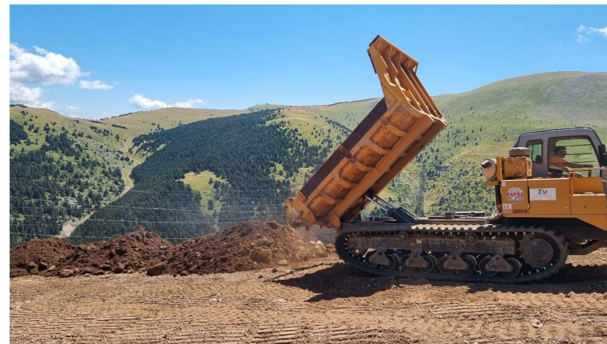
Aportació de terra vegetal prèviament decapada
