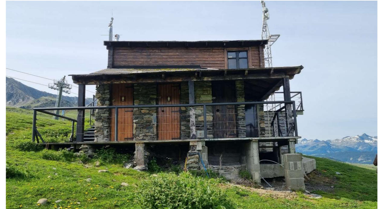
Lavabos i cuina, on es mostra la doble alçada de l'edifici vist de la façana orientada a la vall.
