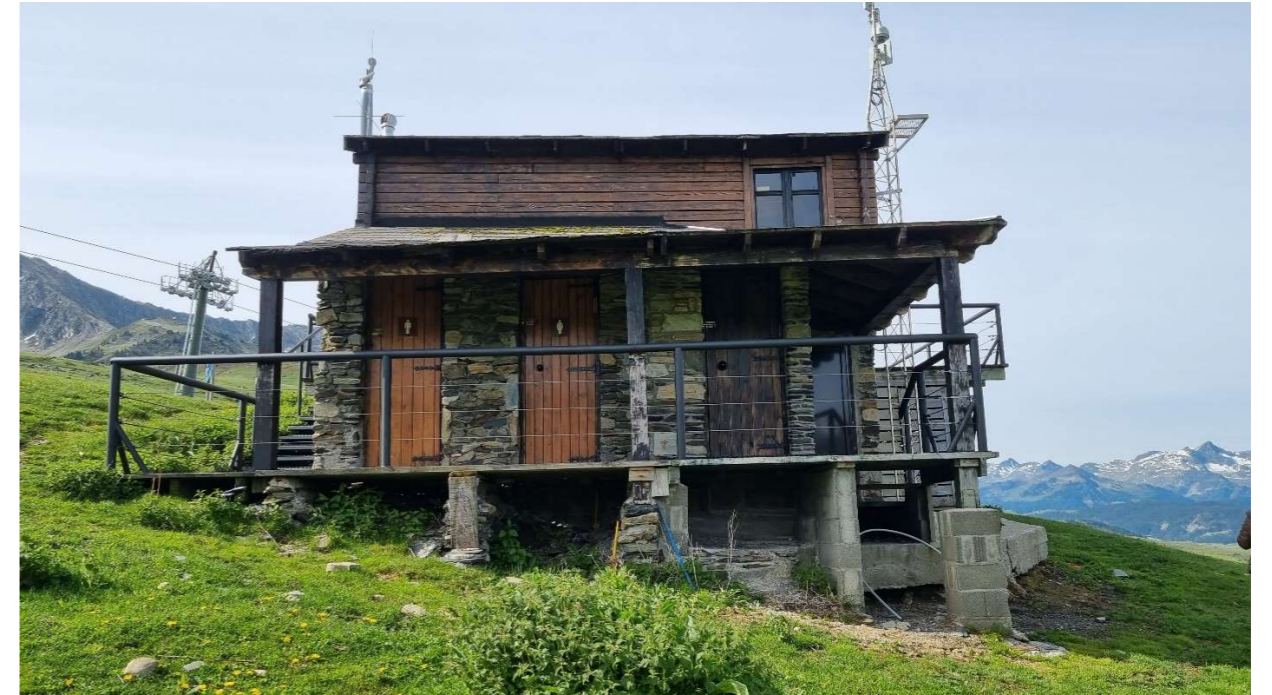
Lavabos i cuina, on es mostra la doble alçada de l'edifici vist de la façana orientada a la vall.
