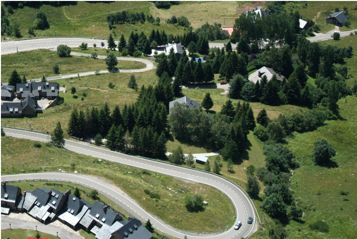
Vista general posterior aèria PE-3 Font: PAMPOLS ARQUITECTE SLP
