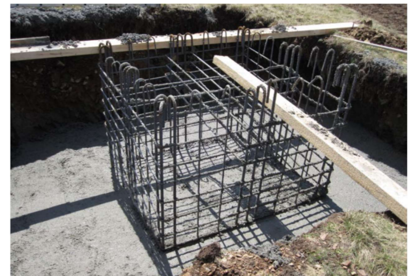
Obra civil de torres de línia i de les estacions.
