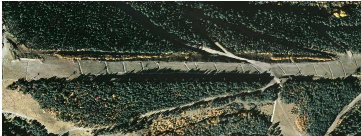
Rases de control de l'erosió en una pista d'esquí
