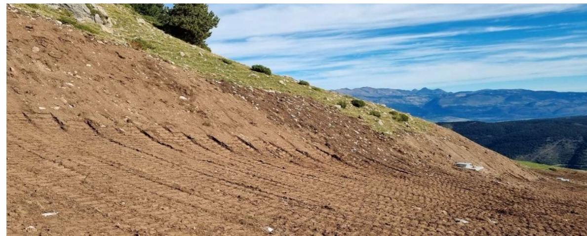
Exemple de remuntada de terres en la coronació del desmunt.
